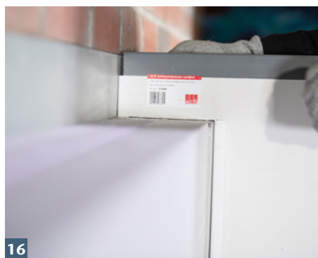
16 ACO Aufstockelement aufsetzen.
