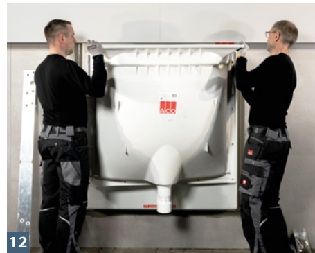
12 ACO Lichtschacht mit eingelegtem Rost anhängen und andrücken.
