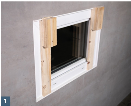
1 Bauseitig erstellte Montagehilfen einsetzen.
