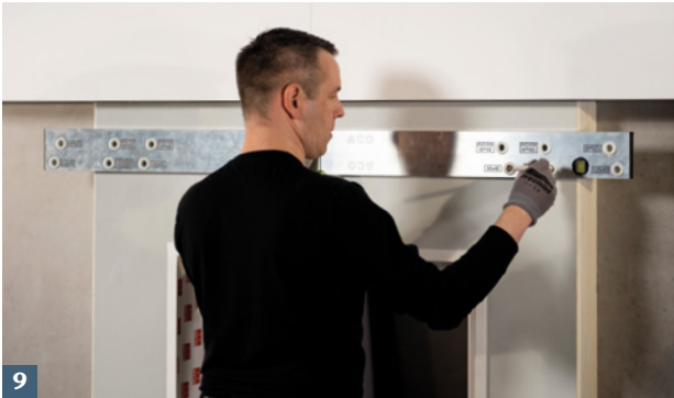
9 Obere Lichtschachtbefestigungspunkte mit ACO Bohrschablone anzeichnen.
