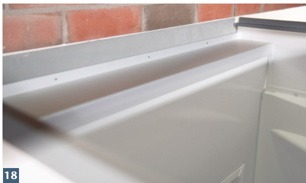
18 ACO Abdeckprofil montieren.
