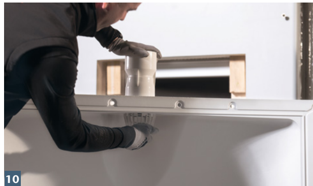
10 ACO Rückstauverschluss anbringen.
