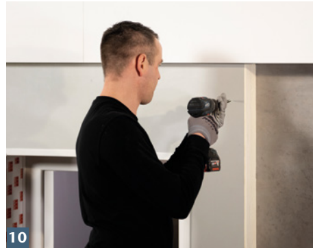
10 Die oberen beiden Schrauben für die Lichtschachtbefestigung eindrehen.
