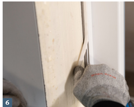
Kanthölzer und Montagehilfen entfernen. Schalungsdichtung aus ACO Therm® Leibungskellerfenster entfernen.
