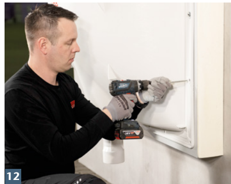
12 Weitere zwei Schrauben je Lichtschachtseite eindrehen.
