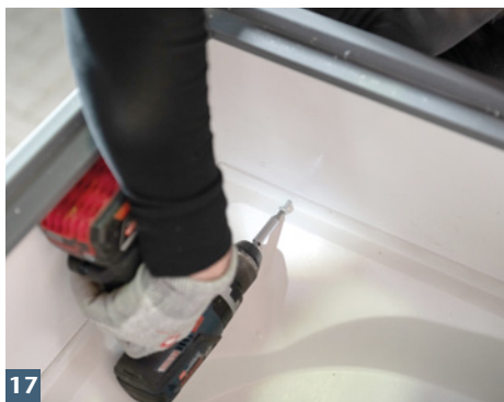
17 ACO Aufstockelement mit Lichtschacht verschrauben.
