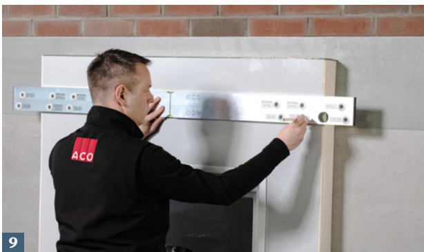
7 ACO Dämmungsanschlussprofil in Nut des ACO Therm® Leibungskellerfensters einklicken.
