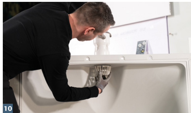
10 ACO Rückstauverschluss anbringen.
