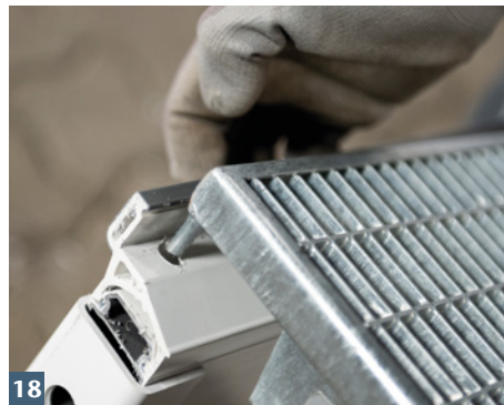
16 Wandseitige Ausklinkung zur Anpassung an den Schwellenbereich vornehmen.
