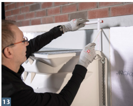
13 Ausklüpfungsbereich für Aufstockelement ermitteln.
