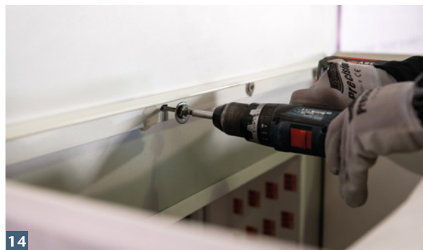
14 Wandanschlusswinkel für wandseitige Auflagerung des Aufstockelements montieren.
