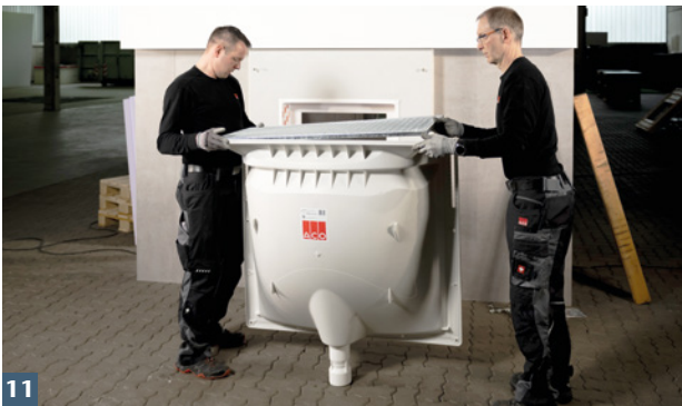
11 Lichtschacht mit eingelegtem Rost anhängen.
