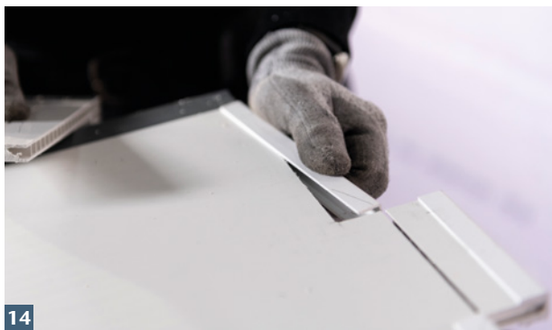
Wandanschlussprofile auf Schnittflächen stecken.
