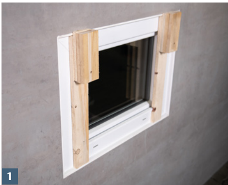
1 Bauseitig erstellte Montagehilfen einsetzen.
