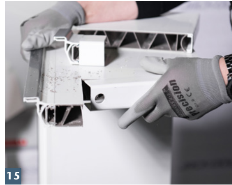
Wandanschlussprofile auf Schnittflächen aufstecken.
