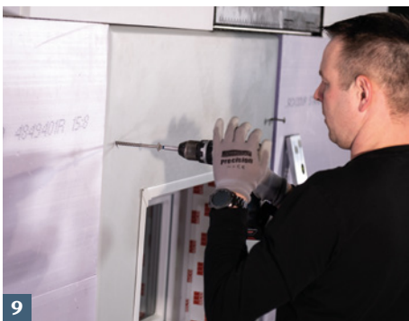
9 Die oberen beiden Schrauben für die Lichtschachbefestigung eindrehen.
