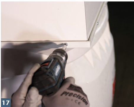
ACO Aufstockelement in Lichtschacht stellen und verschrauben.
