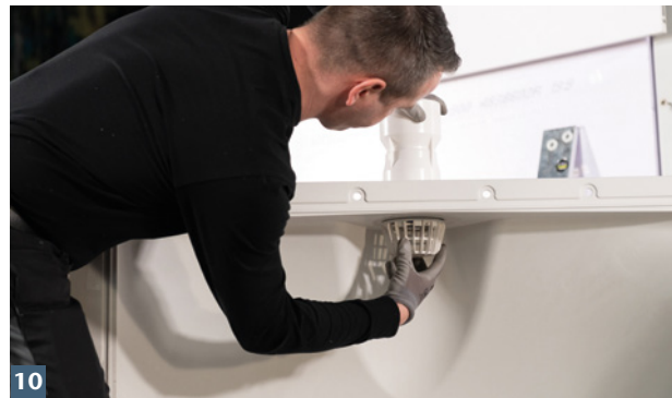
8 Obere Lichtsachtbefestigungspunkte mit ACO Bohrschablone anzeichnen.
