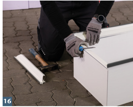
16 Rostauflegeprofil von Aufstockelement entfernen.
