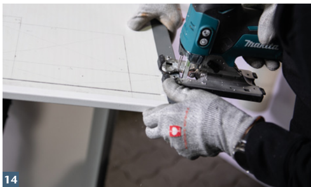
14 ACO Aufstockelement und Wandanschlussprofile mit Stichsäge an rückspringende Klinkerfassade anpassen.
