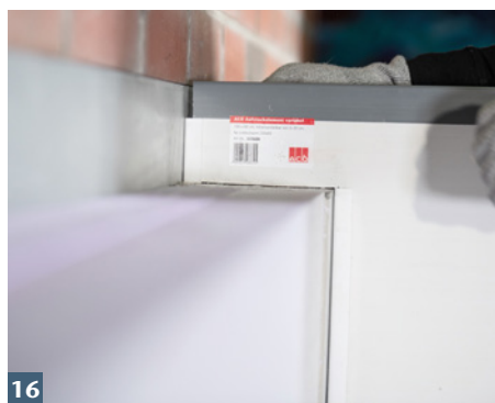
16 ACO Aufstockelement aufsetzen.
