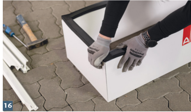
Dichtungsrahmen auf Aufstockelement aufstecken.
