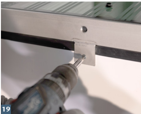
Glasabdeckung auflegen und anschrauben.
