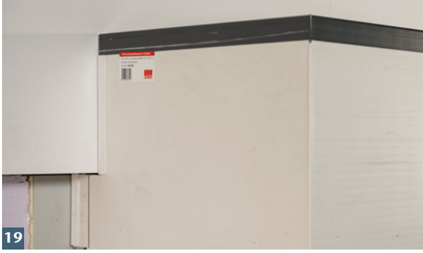
Wandanschlussprofile gegen Dämmung schieben und Rost einlegen.
