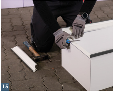
Rostauflageprofil vom Aufstockelement entfernen.
