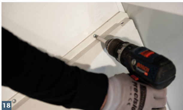
Aufstockelement mit Lichtschart von innen verschrauben.
