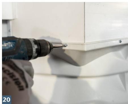
20 Aufstockelement mit Lichtschacht verschrauben.
