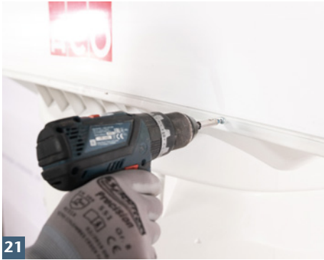
Aufstockelement mit Lichtschacht verschrauben.
