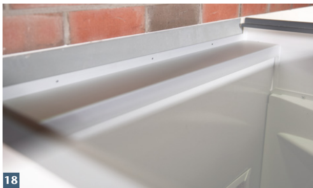
18 ACO Abdeckprofil montieren.
