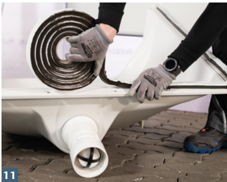
11 Selbstklebendes ACO Dichtfixband auf sauberen Lichtschachtflansch aufkleben.
