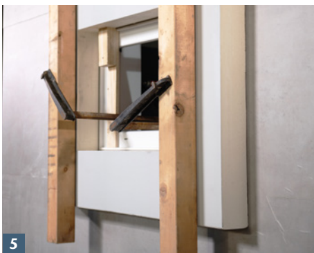
ACO Therm® Block ankleben und mit Kanthölzern und Zwingen für ca. 1 Stunde fixieren.
