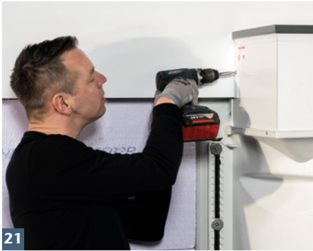
ACO Aufstockelement mit Wandanschlussprofilen verschrauben.
