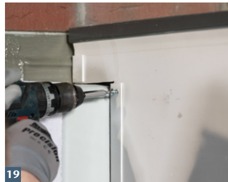
ACO Aufstockelement mit Lichtschacht und Wandanschlussprofilen verschrauben.
