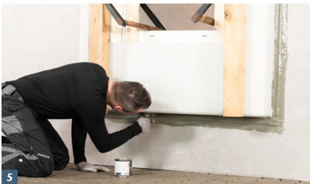
3 ACO Therm® Block ankleben und mit Kanthölzern und Zwingen für ca. 1 Stunde fixieren.
