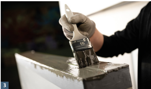
Schnittfläche mit ACO Aqua Blocker abdichten.
