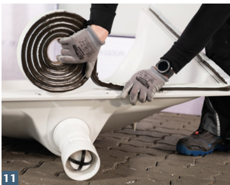
11 Selbstklebendes ACO Dichtfixband auf sauberen Lichtschachtflansch aufkleben.
