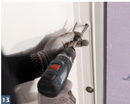
13 Schrauben rundum mit Kontakt zum ACO Dichtfixband eindrehen.
