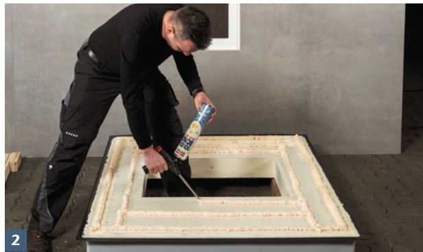
2 Dämmplattenkleber aufspritzen.
