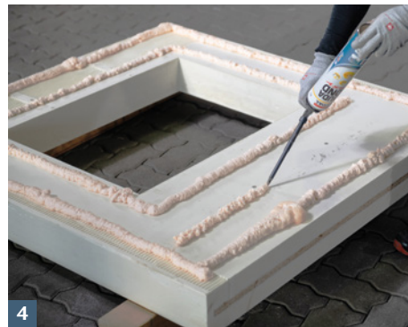
Dämmplattenkleber aufspritzen.
