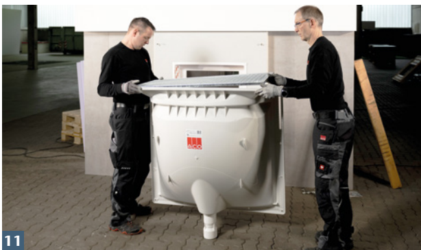
11 Lichtschacht mit eingelegtem Rost anhängen.
