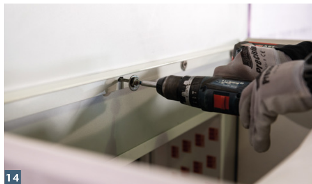
14 Wandanschlusswinkel für wandseitige Auflagerung des Aufstockelements montieren.
