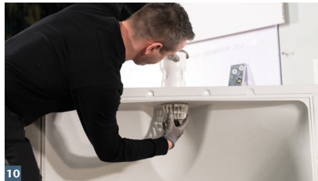
10 ACO Rückstauverschluss anbringen.
