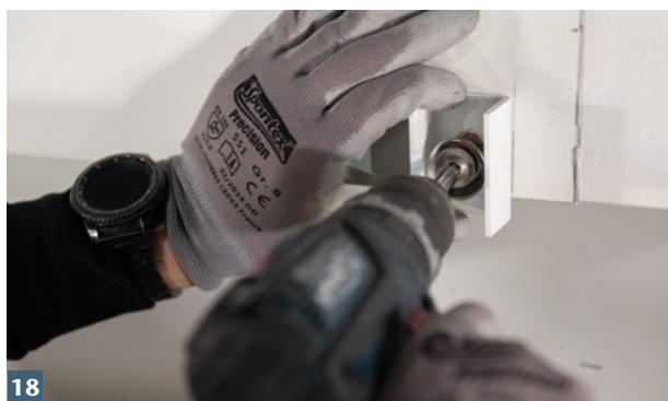
18 Wandanschlussprofile vom Aufstockelement abnehmen und mit ACO Therm® Block und WDVS verschrauben.
