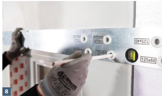
8 Obere Lichtschachtbefestigungspunkte anzeichnen.
