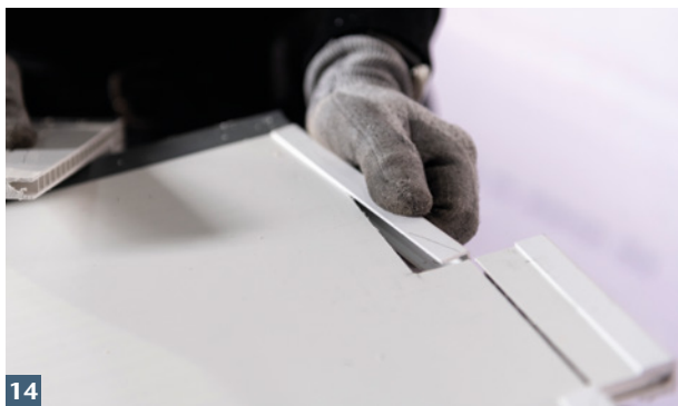
Wandanschlussprofile auf Schnittflächen stecken.
