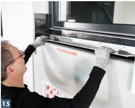
Stahlwinkel für Rinnenauflage montieren.
