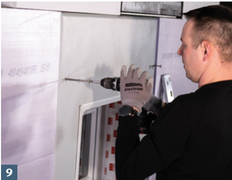
9 Die oberen beiden Schrauben für die Lichtschachtbefestigung eindrehen.
