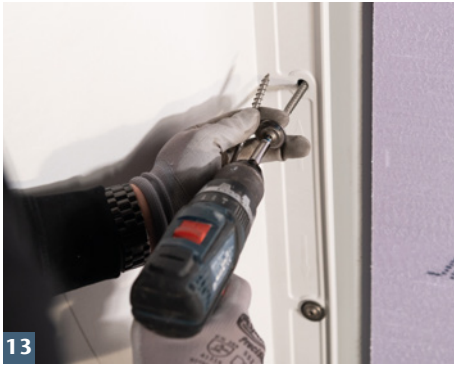
Schrauben rundum mit Kontakt zum ACO Dichtfixband eindrehen.
