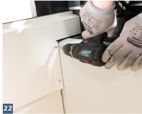
Wandanschlussprofile mit Aufstockelement verschrauben.
