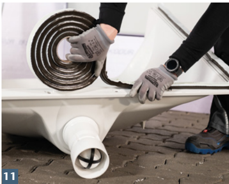
11 Selbstklebendes ACO Dichtfixband auf sauberen Lichtschachtflansch aufkleben.
