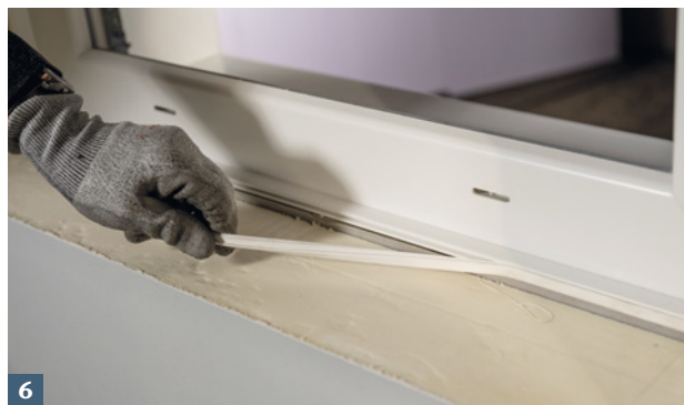
Kanthölzer und Montagehilfen entfernen. Schalungsdichtung aus ACO Therm® Leibungsrahmen entfernen.
