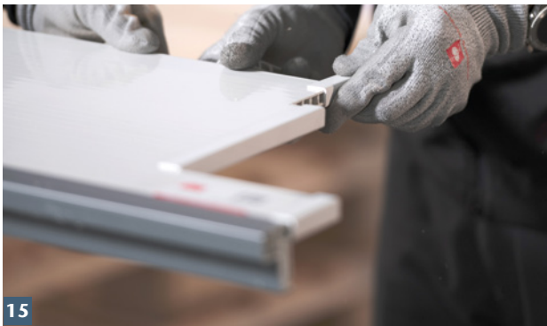
15 Abschnitte der Wandanschlussprofile auf Schnittflächen stecken.
