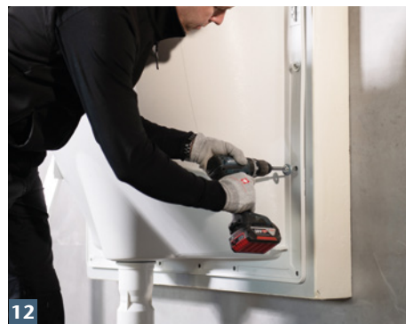
10 Die beiden oberen Schrauben für die Lichtschachtbefestigung eindrehen.
