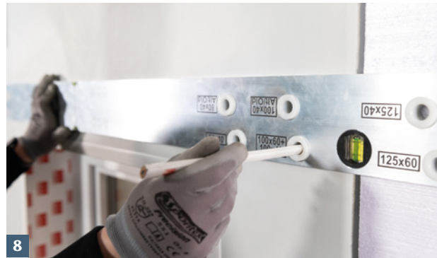
8 Obere Lichtschachtbefestigungspunkte anzeichnen.
