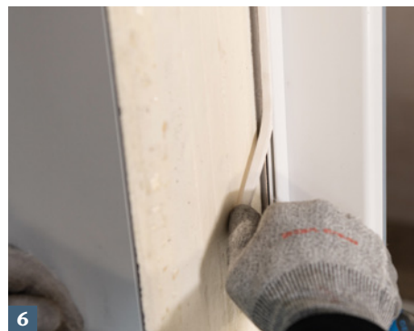
6 Kanthölzer und Montagehilfen entfernen. Schalungsdichtung aus ACO Therm® Leibungskellerfenster entfernen.
