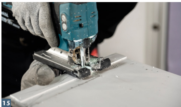
15 ACO Aufstockelement und Wandanschlussprofile mit Stichsäge an vorspringendes WDVS anpassen.
