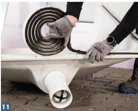
11 Selbstklebendes ACO Dichtfixband auf sauberen Lichtschachtflansch aufkleben.
