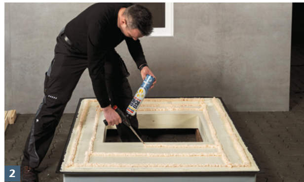
2 Dämmplattenkleber aufspritzen.
