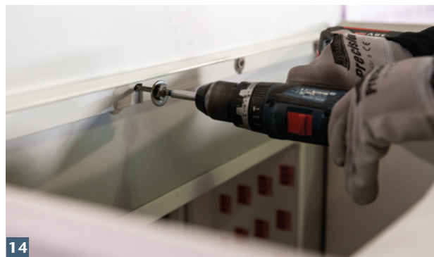
14 Wandanschlusswinkel für wandseitige Auflagerung des Aufstockelements montieren.
