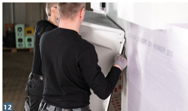
12 ACO Lichtschacht mit eingelegtem Rost anhängen und andrücken.
