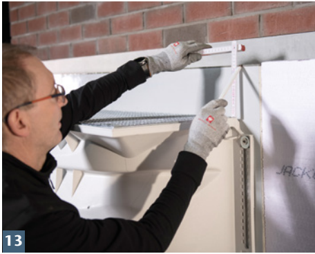
13 Ausklüpfungsbereich für Aufstockelement ermitteln.
