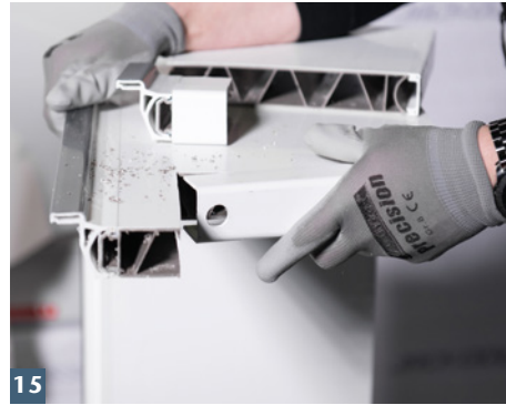
Wandanschlussprofile auf Schnittflächen aufstecken.
