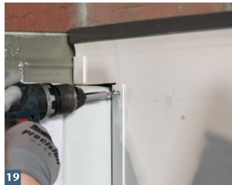
ACO Aufstockelement mit Lichtschacht und Wandanschlussprofilen verschrauben.
