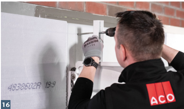
Wandanschlussprofile vom Aufstockelement abnehmen und mit ACO Therm® Block verschrauben.
