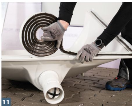
11 Selbstklebendes ACO Dichtfixband auf sauberen Lichtschachtflansch aufkleben.
