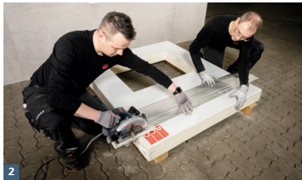
ACO Therm® Block in der Höhe kürzen.
