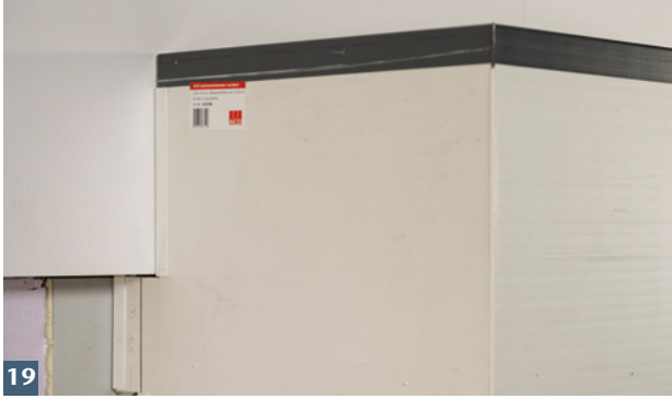
Wandanschlussprofile gegen Dämmung schieben und Rost einlegen.
