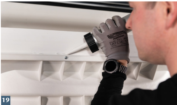
19 Übergang Aufstockelement zum ACO Therm® Lichtsacht abdichten.
