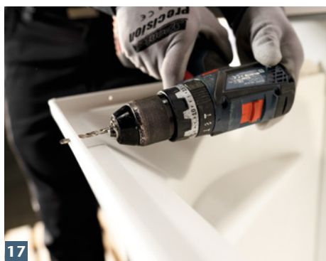
ACO Therm® Lichtschart für Montage des Aufstockelements vorbohren.
