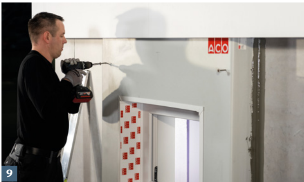
9 Die oberen beiden Schrauben für die Lichtschachtbefestigung eindrehen.
