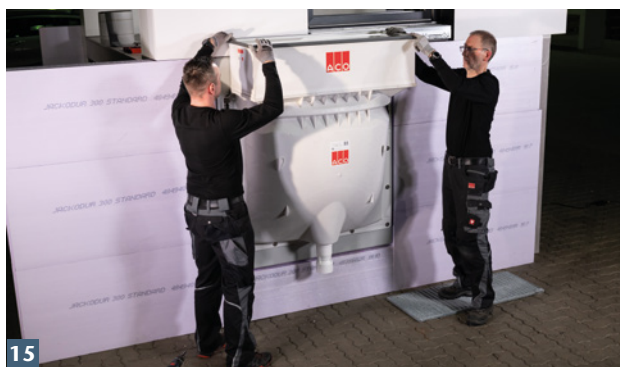
Aufstockelement in Lichtschacht stellen.
