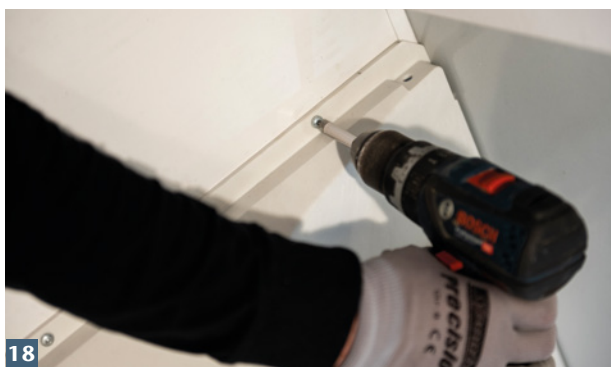
Aufstockelement mit Lichtschart von innen verschrauben.
