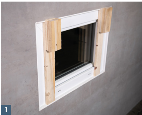
Bauseitig erstellte Montagehilfen einsetzen.
