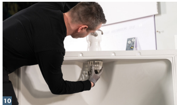
10 ACO Rückstauverschluss anbringen.
