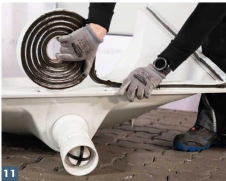
11 Selbstklebendes ACO Dichtfixband auf sauberen Lichtschachtflansch aufkleben.
