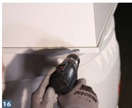
ACO Aufstockelement mit Lichtschacht verschrauben.
