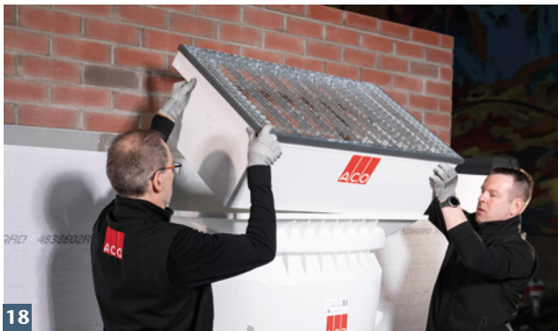
ACO Aufstockelement in Wandanschlussprofile einführen und in Lichtschachtrostaufgabe drücken.
