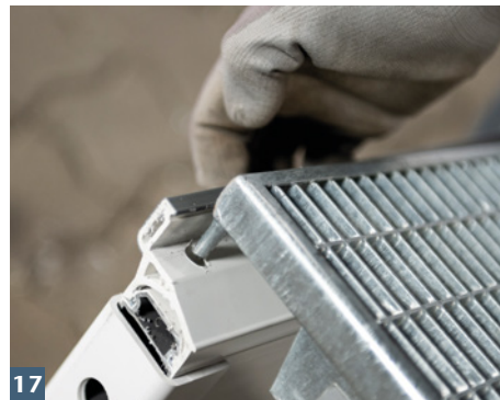
Rostzapfenlöcher ins Aufstockelement bohren und Rost einlegen.
