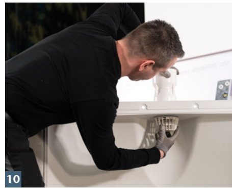
10 ACO Rückstauverschluss anbringen.
