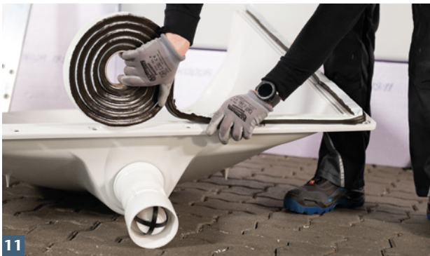
11 Selbstklebendes ACO Dichtfixband auf sauberen Lichtschachtflansch aufkleben.
