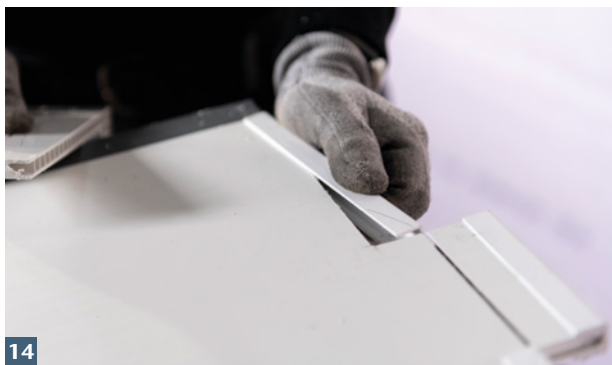
Wandanschlussprofile auf Schnittflächen stecken.
