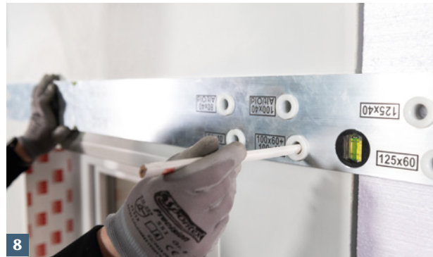
8 Obere Lichtschachtbefestigungspunkte mit ACO Bohrschablone anzeichnen.
