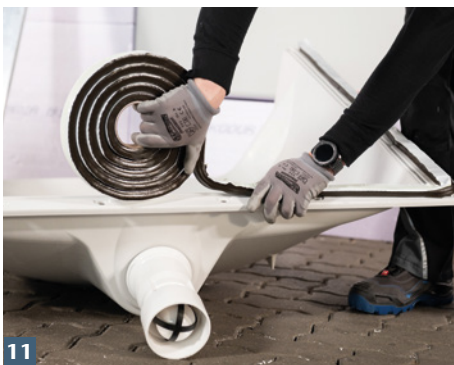
11 Selbstklebendes ACO Dichtfixband auf sauberen Lichtschachtflansch aufkleben.
