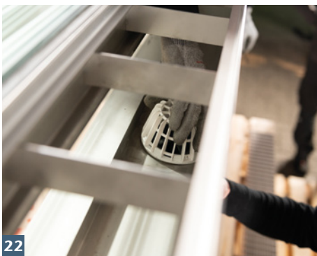
Lüftungskasten vorsetzen, anschrauben und Rückstauverschluss montieren.
