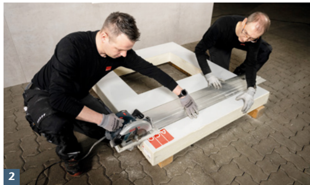
ACO Therm® Block in der Höhe kürzen.
