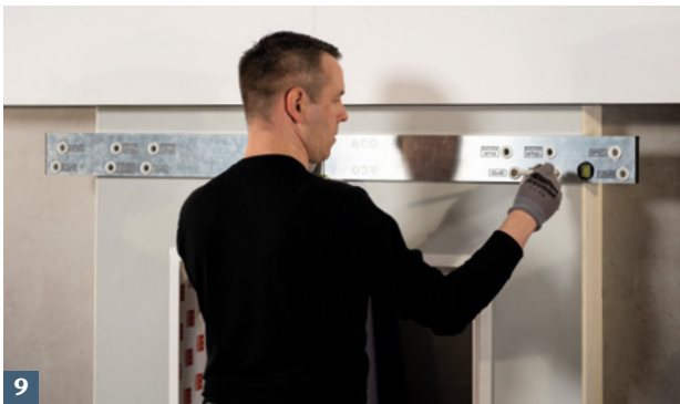
9 Obere Lichtschachtbefestigungspunkte mit ACO Bohrschablone anzeichnen.
