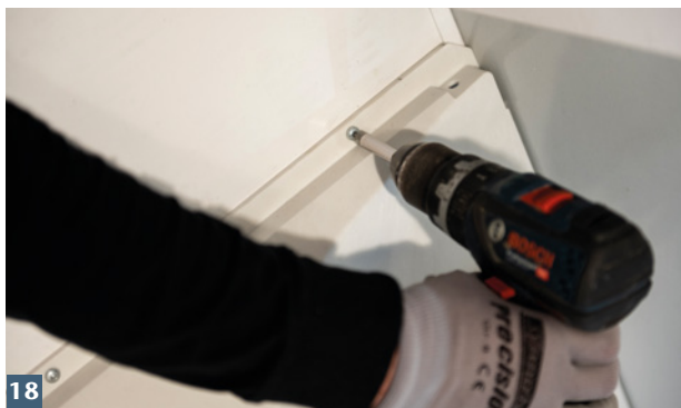
Aufstockelement mit Lichtschart von innen verschrauben.
