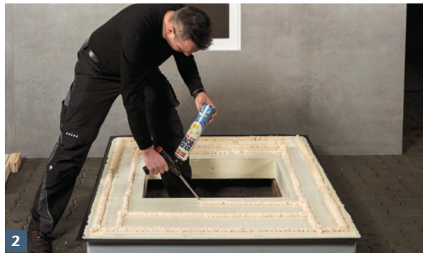
2 Dämmplattenkleber aufsprühen.
