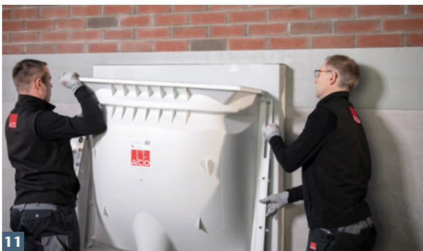
9 Obere Lichtschachtbefestigungspunkte mit ACO Bohrschablone anzeichnen.
