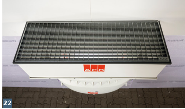
ACO Lichtschachtrost einlegen.
