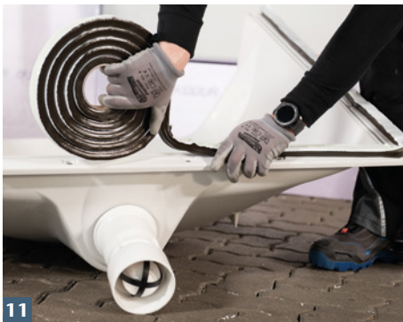
11 Selbstklebendes ACO Dichtfixband auf sauberen Lichtschachtflansch aufkleben.
