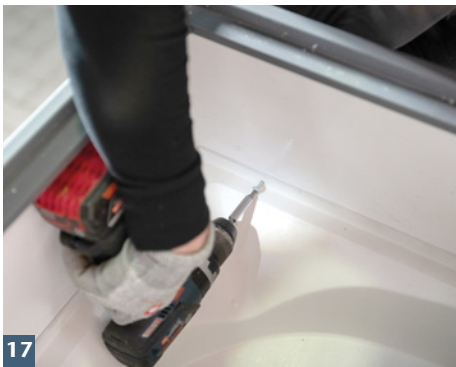
ACO Aufstockelement mit Lichtschacht verschrauben.
