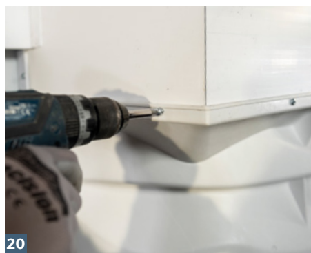
20 Aufstockelement mit Lichtschacht verschrauben.
