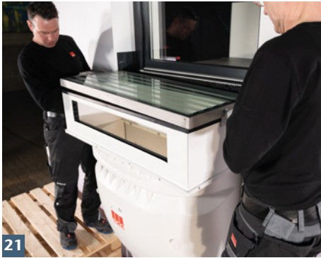
Glasabdeckung auflegen und verschrauben.
