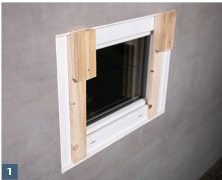
Bauseitig erstellte Montagehilfen einsetzen.
