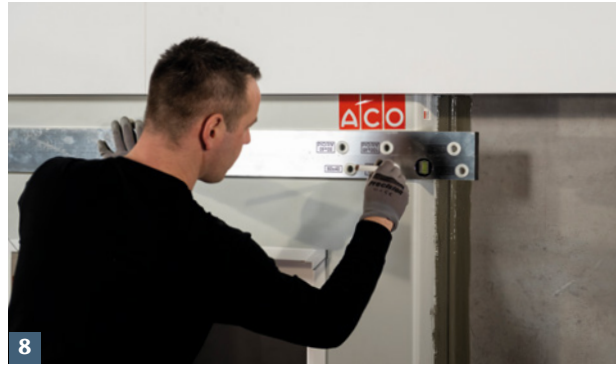
8 Obere Lichtschachtbefestigungspunkte mit ACO Bohrschablone anzeichnen.
