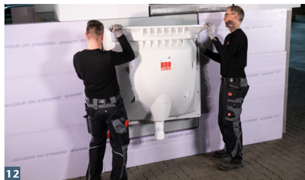
12 ACO Therm® Lichtschacht mit eingelegtem Rost anhängen und andrücken.
