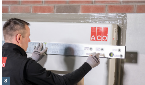
Obere Lichtschachtbefestigungspunkte mit ACO Bohrschablone anzeichnen.
