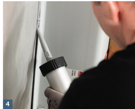
ACO Therm® Block umlaufend mit Aqua Blocker aus Kartusche abdichten.
