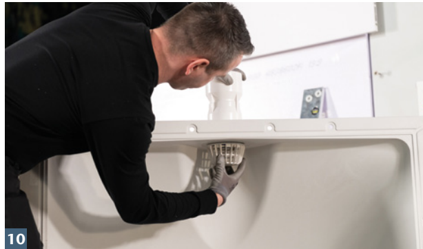
10 ACO Rückstauverschluss anbringen.
