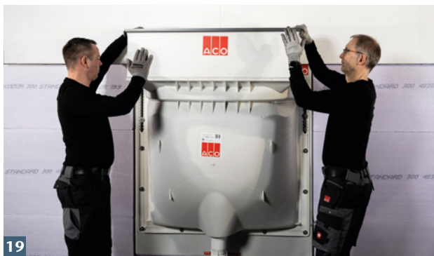
19 ACO Aufstockelement in Wandanschlussprofile einführen und in Lichtschachtrostaufgabe drücken.
