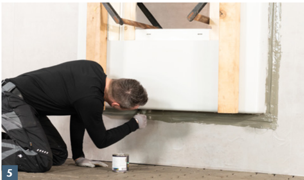
ACO Therm® Block umlaufend in 2 Arbeitsgängen andichten. Übergang von ACO Therm® Block zur Kellerdecke z.B. mit Aqua Blocker gegen Hinterläufigkeit abdichten.
