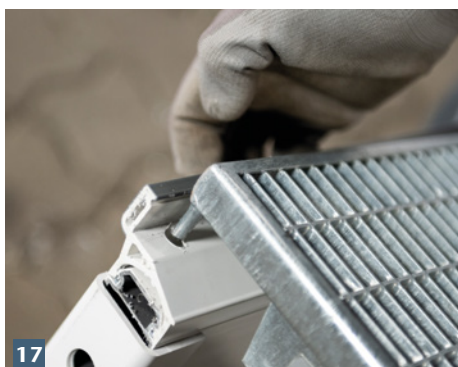
17 Rostzapfenlöcher ins Aufstockelement bohren und Rost einlegen.
