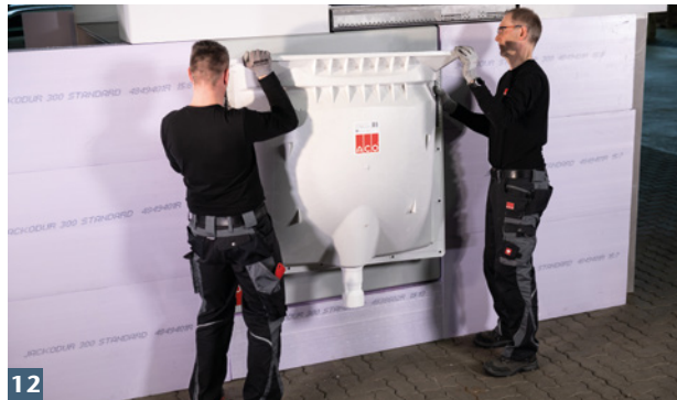
12 ACO Therm® Lichtschacht mit eingelegtem Rost anhängen und andrücken.
