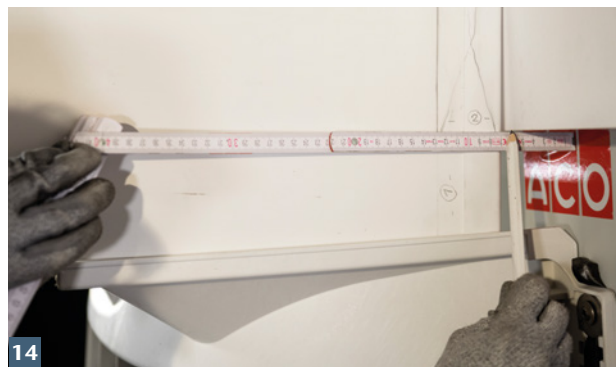
14 Ausklingungsbereich für Aufstockelement ermitteln.
