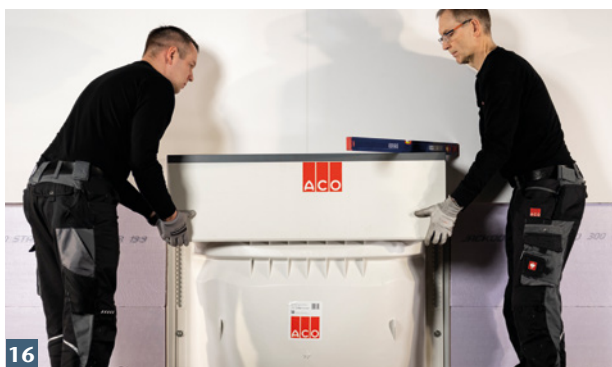
Aufstockelement über Lichtschart schieben und ausrichten.
