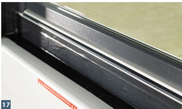
Abdichtung zur Terrassentür z.B. mit KSK-Bahn oder Aqua Blocker herstellen. Kondensatöffnung ggf. aussparen.
