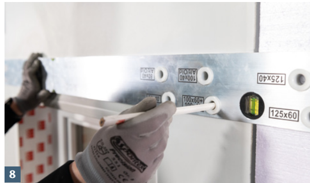
8 Obere Lichtschachtbefestigungspunkte anzeichnen.
