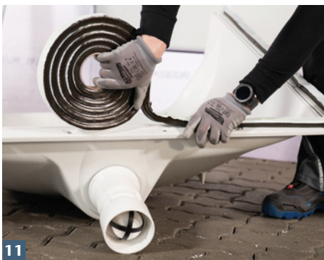
11 Selbstklebendes ACO Dichtfixband auf sauberen Lichtschachtflansch aufkleben.
