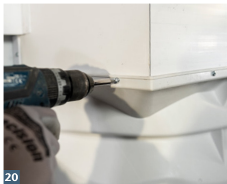
20 Aufstockelement mit Lichtschacht verschrauben.
