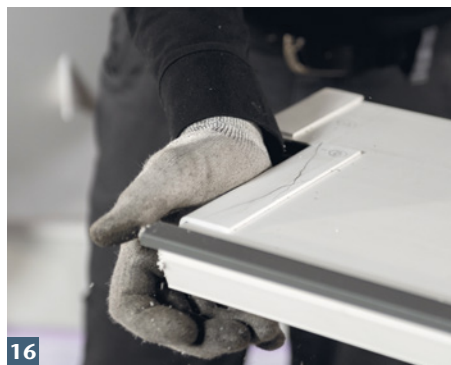
16 Wandanschlussprofile auf Schnittflächen stecken.
