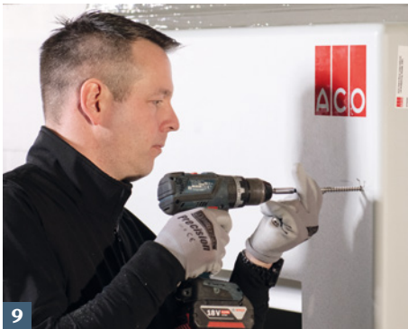
Die beiden oberen Schrauben für die Lichtschachtbefestigung eindrehen.
