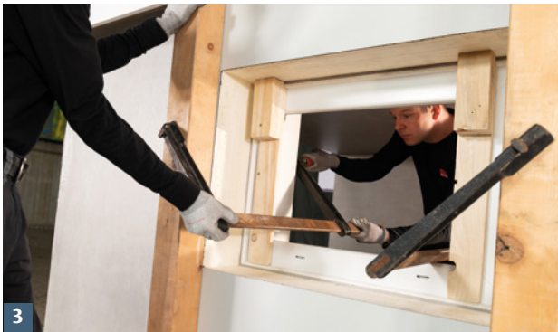
ACO Therm® Block ankleben und mit Kanthölzern und Zwingen für ca. 1 Stunde fixieren.
