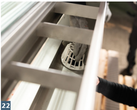
Lüftungskasten vorsetzen, anschrauben und Rückstauverschluss montieren.
