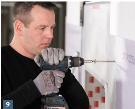
9 Die oberen beiden Schrauben für die Lichtsachtbefestigung eindrehen.
