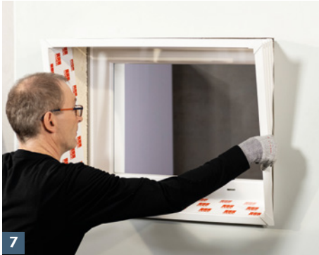
ACO Dämmungsanschlussprofil in Nut des ACO Therm® Leibungskellerfensters einklicken.
