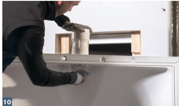
ACO Rückstauverschluss anbringen.
