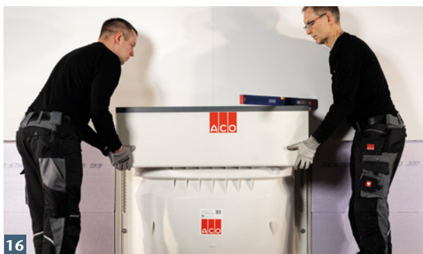
Aufstockelement über Lichtschart schieben und ausrichten.
