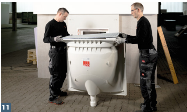
11 Lichtschacht mit eingelegtem Rost anhängen.
