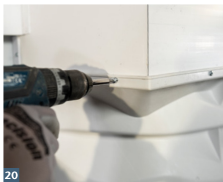
20 Aufstockelement mit Lichtschacht verschrauben.
