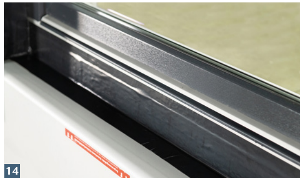
14 Abdichtung zur Terrassentür z.B. mit KSK-Bahn oder Aqua Blocker herstellen. Kondensatöffnung ggf. aussparen.
