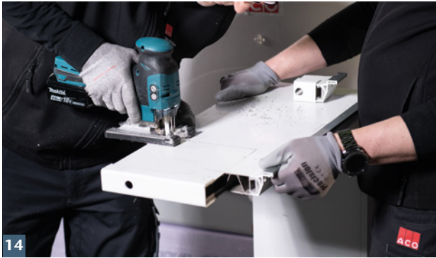
ACO Aufstockelement und Wandanschlussprofile mit Stichsäge an rückspringende Klinkerfassade anpassen.
