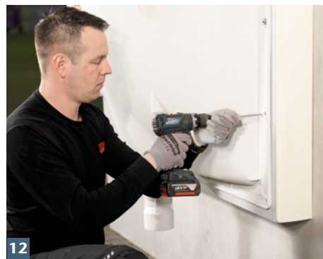
12 Weitere zwei Schrauben je Lichtschachtseite eindrehen.
