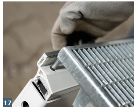
Rostzapfenlöcher ins Aufstockelement bohren und Rost einlegen.
