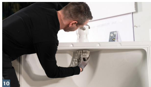
10 ACO Rückstauverschluss anbringen.
