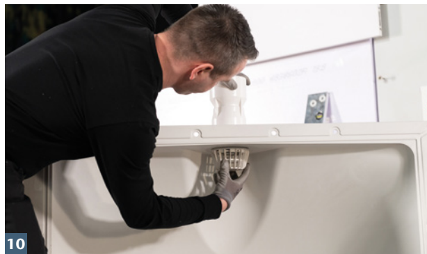
10 ACO Rückstauverschluss anbringen.
