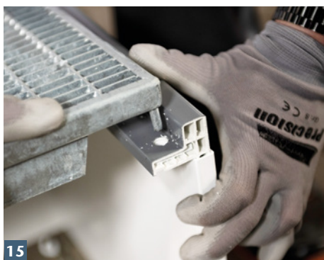
Rostzapfenlöcher in das Aufstockelement bohren und Rost einlegen.
