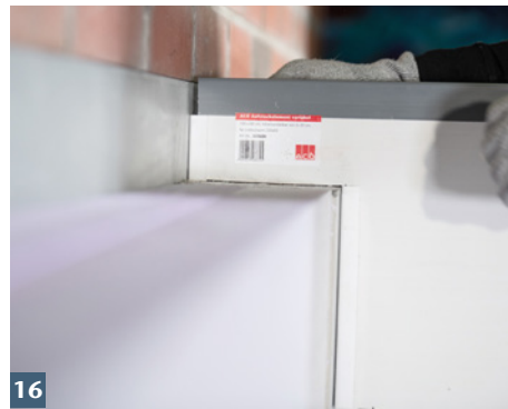
16 ACO Aufstockelement aufsetzen.
