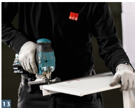
ACO Aufstockelement und Wandanschlussprofile mit Stichsäge an vorspringendes WDVS anpassen.
