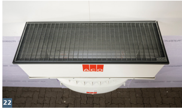
ACO Lichtschachtrost einlegen.
