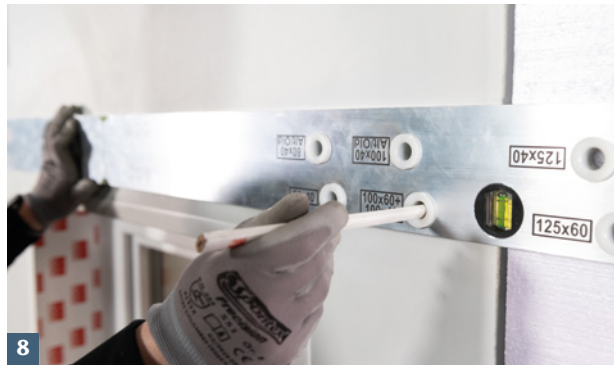
8 Obere Lichtschachtbefestigungspunkte mit ACO Bohrschablone anzeichnen.
