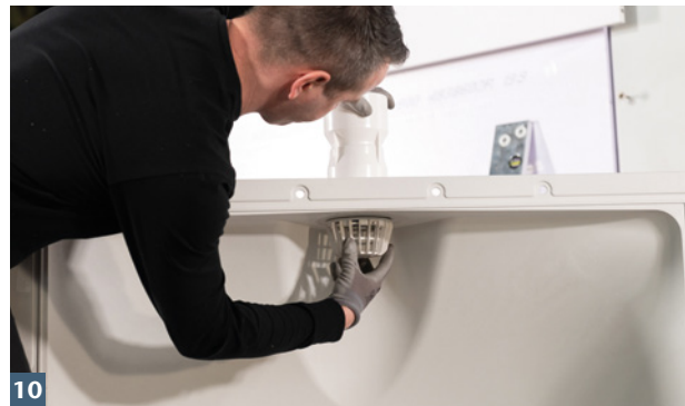
10 ACO Rückstauverschluss anbringen.
