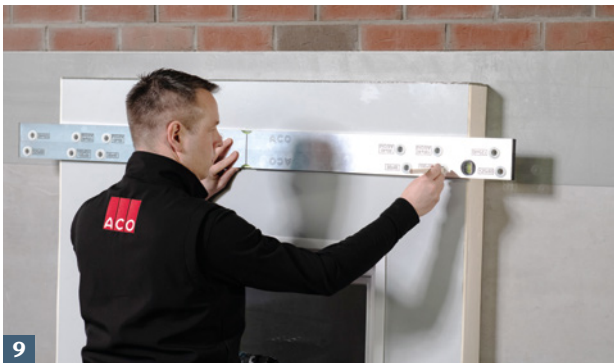
7 ACO Dämmungsanschlussprofil in Nut des ACO Therm® Leibungskellerfensters einklicken.
