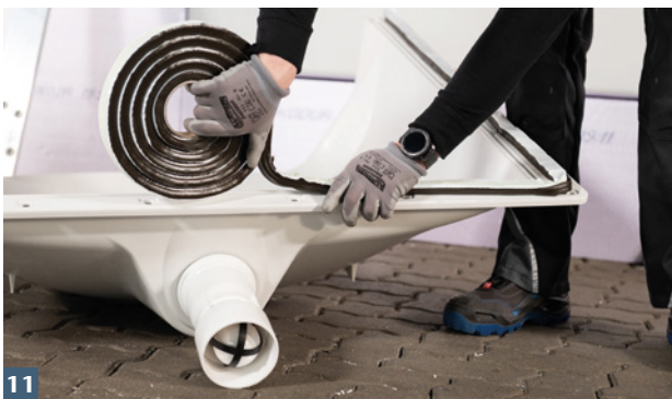
11 Selbstklebendes ACO Dichtfixband auf sauberen Lichtsachtflansch aufkleben.
