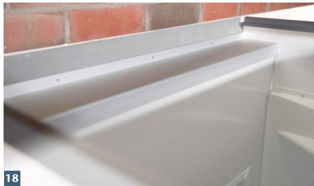
18 ACO Abdeckprofil montieren.
