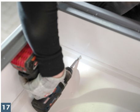
17 ACO Aufstockelement mit Lichtschacht verschrauben.
