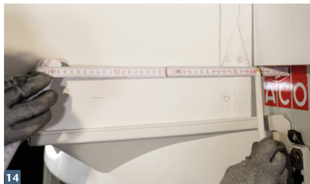
14 Ausklingungsbereich für Aufstockelement ermitteln.
