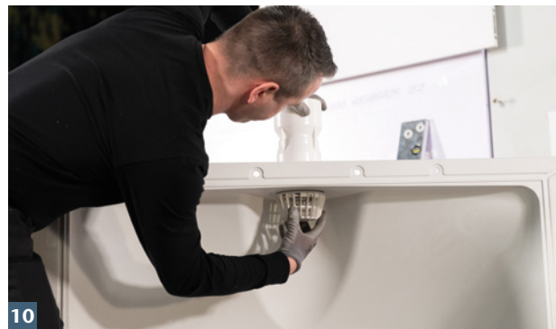
10 ACO Rückstauverschluss anbringen.
