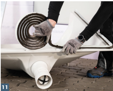
11 Selbstklebendes ACO Dichtfixband auf sauberen Lichtschachtflansch aufkleben.
