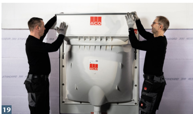
19 ACO Aufstockelement in Wandanschlussprofile einführen und in Lichtschachtrostaufgabe drücken.
