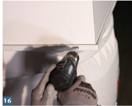
ACO Aufstockelement mit Lichtschacht verschrauben.
