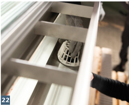
Lüftungskasten vorsetzen, anschrauben und Rückstauverschluss montieren.
