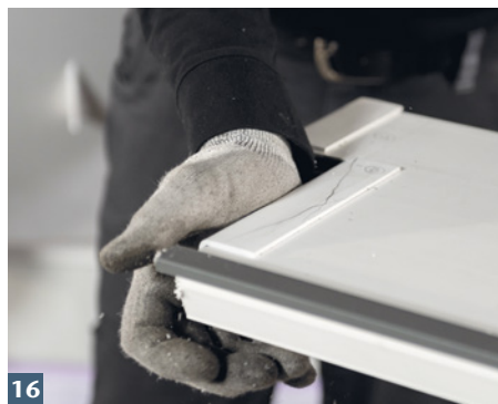
16 Wandanschlussprofile auf Schnittflächen stecken.
