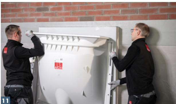
9 Obere Lichtschachtbefestigungspunkte mit ACO Bohrschablone anzeichnen.
