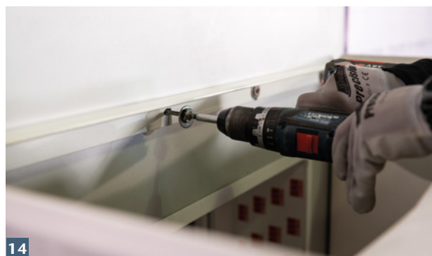
14 Wandanschlusswinkel für wandseitige Auflagerung des Aufstockelements montieren.
