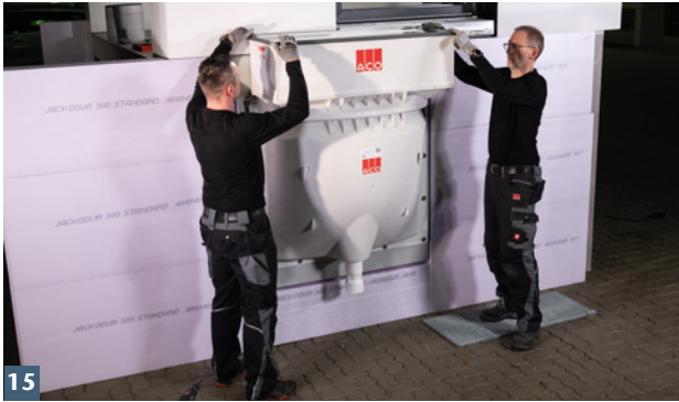
Aufstockelement in Lichtschacht stellen.
