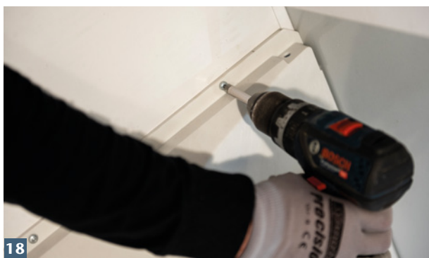
Aufstockelement mit Lichtschart von innen verschrauben.
