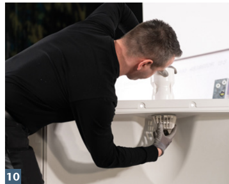
10 ACO Rückstauverschluss anbringen.
