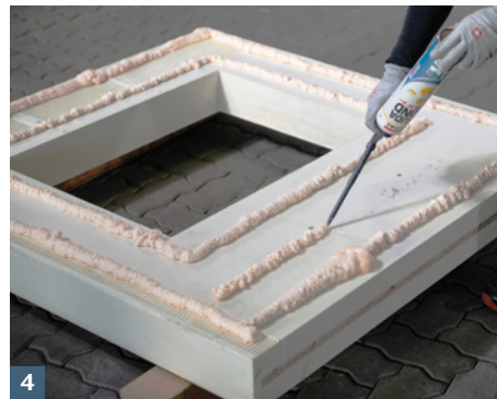
Dämmplattenkleber aufsprühen.
