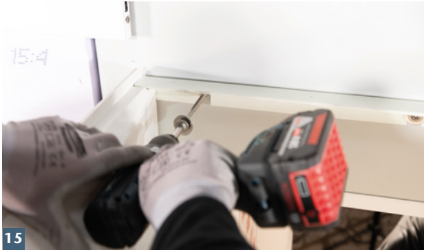
15 Wandanschlusswinkel für wandseitige Auflagerung des Aufstockelements montieren.
