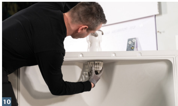
10 ACO Rückstauverschluss anbringen.
