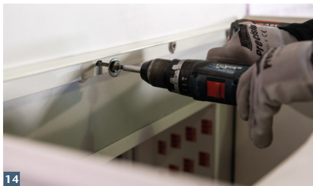
14 Wandanschlusswinkel für wandseitige Auflagerung des Aufstockelements montieren.
