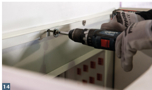
14 Wandanschlusswinkel für wandseitige Auflagerung des Aufstockelements montieren.
