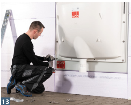
11 Selbstklebendes ACO Dichtfixband auf sauberen Lichtschachtflansch aufkleben.
