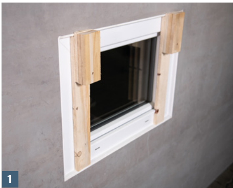
1 Bauseitig erstellte Montagehilfen einsetzen.
