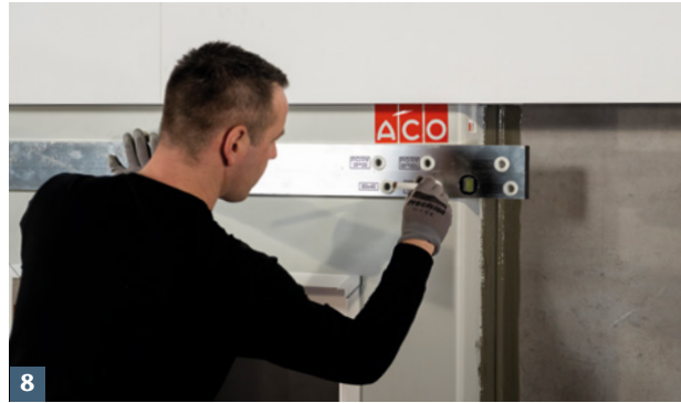
8 Obere Lichtschachtbefestigungspunkte mit ACO Bohrschablone anzeichnen.
