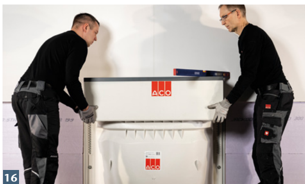
Aufstockelement über Lichtschart schieben und ausrichten.
