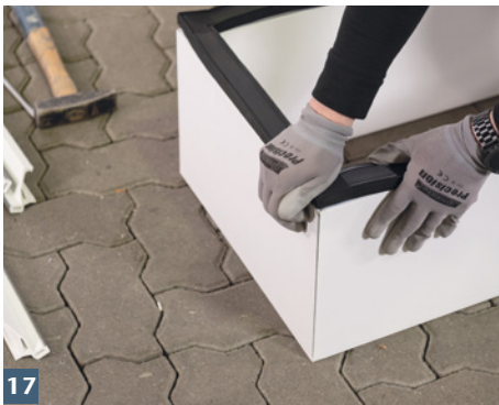
17 Dichtungsrahmen auf Aufstockelement aufstecken.
