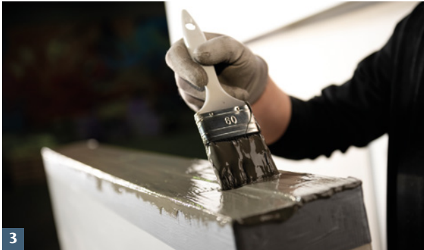
Schnittfläche mit ACO Aqua Blocker abdichten.
