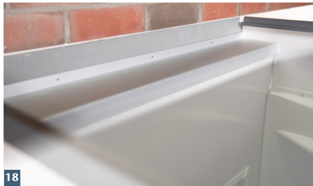
ACO Abdeckprofil montieren.
