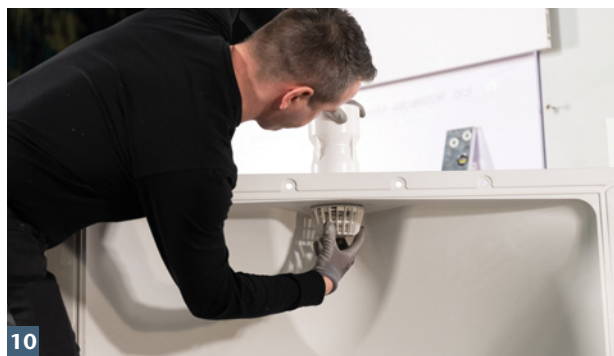
10 ACO Rückstauverschluss anbringen.
