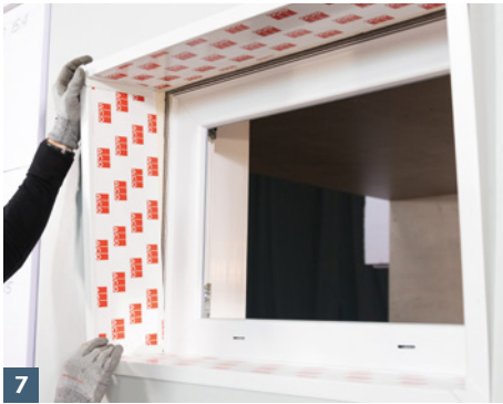
7 ACO Dämmungsanschlussprofil in Nut des ACO Therm® Leibungfensters einklicken.
