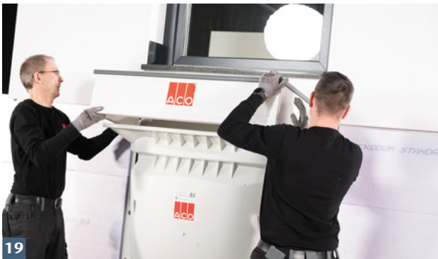
17 Rostzapfenlöcher ins Aufstockelement bohren und Rost einlegen.
