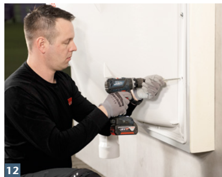
10 Die oberen beiden Schrauben für die Lichtschachtbefestigung eindrehen.
