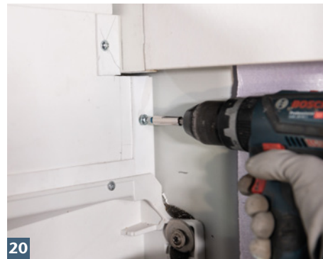
18 Wandanschlussprofile vom Aufstockelement abnehmen und mit ACO Therm® Block und WDVS verschrauben.
