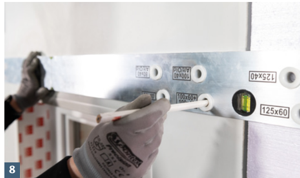
8 Obere Lichtschachtbefestigungspunkte mit ACO Bohrschablone anzeichnen.
