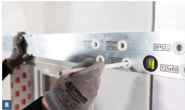
8 Obere Lichtschachtbefestigungspunkte anzeichnen.
