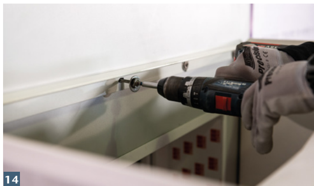
14 Wandanschlusswinkel für wandseitige Auflagerung des Aufstockelements montieren.
