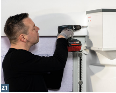
ACO Aufstockelement mit Wandanschlussprofilen verschrauben.
