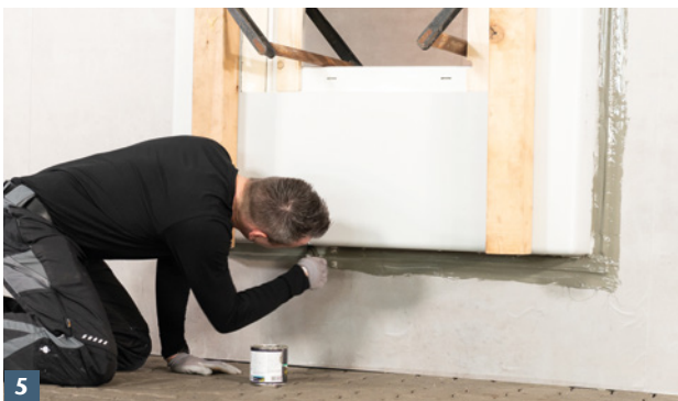
5 ACO Therm® Block umlaufend in 2 Arbeitsgängen andichten. Übergang von ACO Therm® Block zur Kellerdecke z.B. mit Aqua Blocker gegen Hinterläufigkeit abdichten.
