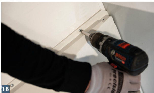
Aufstockelement mit Lichtschart von innen verschrauben.
