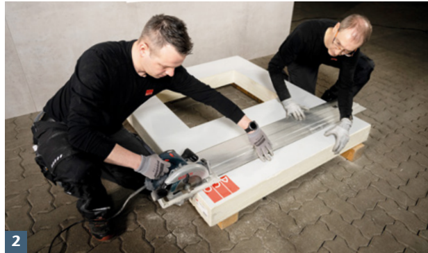
ACO Therm® Block in der Höhe kürzen.
