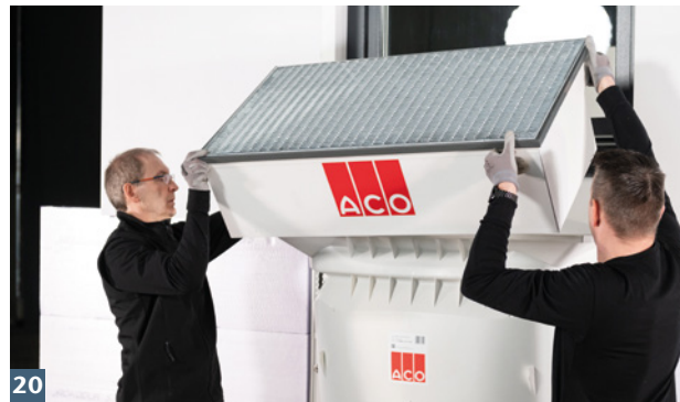
18 Rostzapfenlöcher ins Aufstockelement bohren und Rost einlegen.
