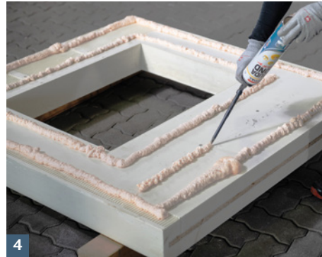
Dämmplattenkleber aufsprühen.
