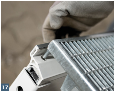
15 ACO Aufstockelement mit Stichsäge in der Höhe kürzen. U-Profile über Schnittfläche stecken.
