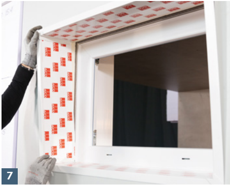
7 ACO Dämmungsanschlussprofil in Nut des ACO Therm® Leibungskellerfensters einklicken.
