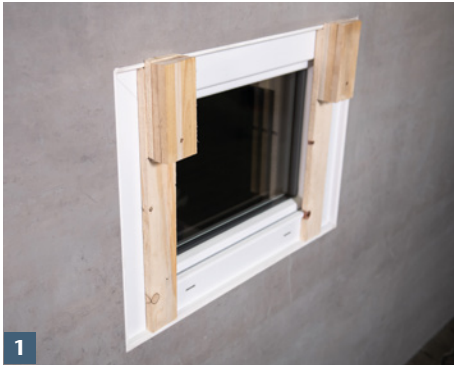
Bauseitig erstellte Montagehilfen einsetzen.
