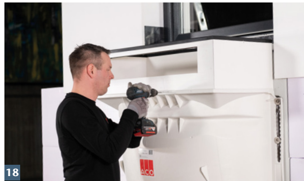
18 Aufsatzelement mit werkseitiger Aussparung für Lüftungskasten mit dem ACO Therm® Lichtsacht verschrauben.
