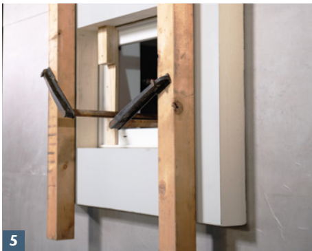
ACO Therm® Block ankleben und mit Kanthölzern und Zwingen für ca. 1 Stunde fixieren.
