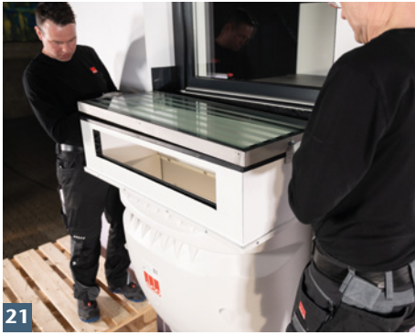
Glasabdeckung auflegen und verschrauben.
