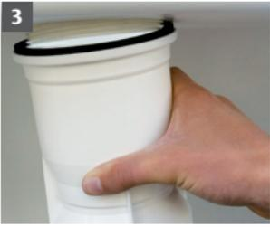
Den Einschraubring von oben durch die Lichtschacht-Entwässerungsöffnung führen. Den Grundkörper von unten auf den Einschraubring schrauben, dabei auf den korrekten Sitz des Gewindes achten, Grundkörper soweit aufschrauben, bis die Dichtung am Lichtschacht anliegt. Mit dem Einschraubring festziehen, dabei den Grundkörper gehalten.
