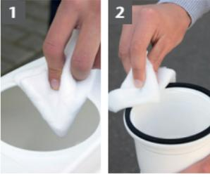
Die Lichtschacht-Entwässerungsöffnung innen- und außenseitig von Schmutz befreien. Die Dichtung des Grundkörpers säubern und dünn mit handelsüblichem Gleitmittel für Steckmuffensystem bestreichen.
