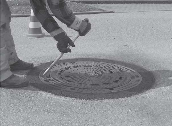
Bedienungsschlüssel an den Entriegelungsöffnungen am Rahmen einsetzen, und mit einer Handbewegung nach außen den Deckel entriegeln
