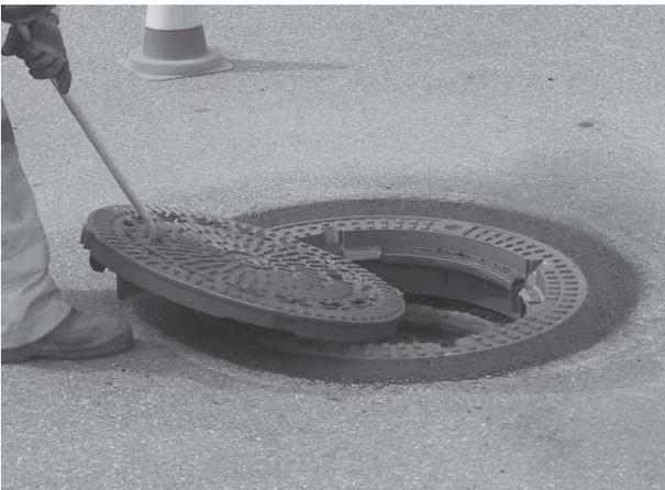
Anschließend den Deckel mit dem Bedienschlüssel an den Aushebeöffnungen herausziehen.
