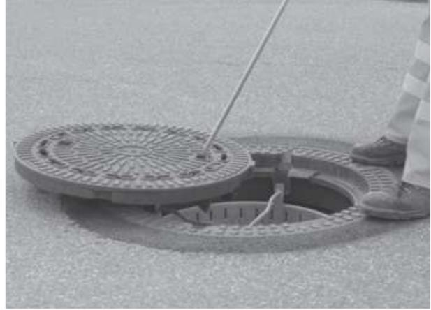
Auflageflächen an Deckel und Rahmen reinigen. Deckel, Rahmen, dämpfende Einlage und Verriegelungsnocken auf Beschädigungen überprüfen, und Deckel unter Beachtung der Einlegesicherung einlegen
