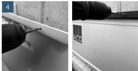
Mit 4 mm Bohrer Rostkante des Lichtschachtes und oder des fixen Aufstockelementes durchbohren. Die Bohrungen in gleichmäßigen Abständen setzen. Anzahl Bohrungen:
