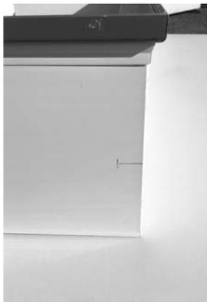
Position der Verstärkungseisen ermitteln und Profilstärke (35 mm) anzeichnen
