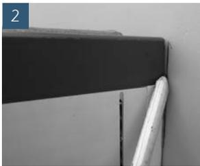
Außenkante des Aufstockelements (Seitenschenkel) anzeichnen
