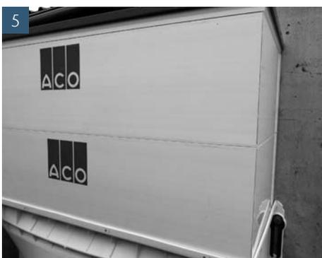
Montage wie auf der vorherigen Seite vorführen. Hierzu alle Wandanschlussprofile mit Perimeterdämmung bzw. Kellerwand verschrauben. Nun Aufstockelemente in Wandanschlussprofile einführen, nach unten schieben und in Lichtschachtrostauflage drücken. Unterstes Aufstockelement mit Lichtschacht verschrauben. Wandabschlussprofile mit Aufstockelemente verschrauben. Siehe hierzu Punkt 9 auf der vorherigen Seite.
