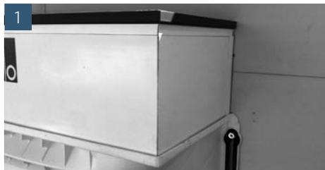
1 Nach erfolgter Lichtschachtmontage das fixe Aufstockelement inklusive eingelegten Rost in die Rostauflage des Lichtschachtes stellen.
