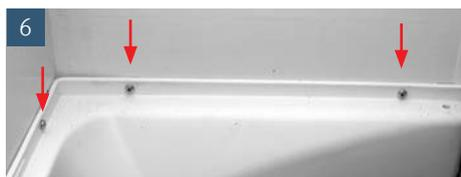
Im Anschluss die Verschraubung von innen nach außen vornehmen. Bitte zuerst die vorderen Schrauben eindrehen.
