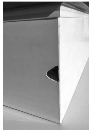
Profilkammer mit weiteren Bohrungen soweit öffnen, so dass Verstärkungseisen entnommen werden kann
