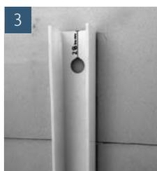
3 Wandanschlussprofil in Lichtschacht-Rostauflage stellen und entsprechend der angezeichneten Markierung ausrichten. Auf richtige Positionierung der Befestigungspunkte achten. Die Befestigungspunkte anzeichnen.
