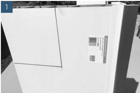
Wandanschlussprofile entfernen und Ausklinkung anzeichnen
