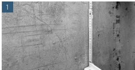
Lichtschacht entsprechend der Lichtschacht-Montageanleitung montieren und im Anschluss Lichtschachtrost entnehmen. Maß von Geländeoberkante bis Oberkante Lichtschacht-Rostkante ermitteln.
