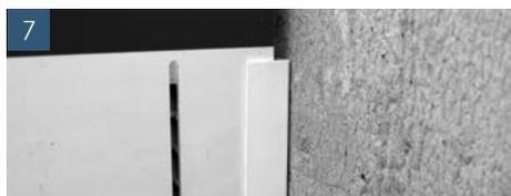
Wandanschlussprofil gegen Wand schieben und Rost einlegen.
