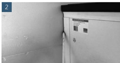
2 Außenkante des Wandanschlussprofils beidseitig auf Montageuntergrund anzeichnen. Aufstockelement vom Lichtschacht nehmen und Wandanschlussprofile vom Aufstockelement entfernen.
