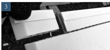
Denn Bereich unterhalb der Kennzeichnung mit einer Eisensäge abtrennen. Hierbei die Schnittführung nutzen. (Dieser Punkt entfällt bei der Montage vom höhenverstellbaren Aufstockelement auf ein fixes Aufstockelement.)
