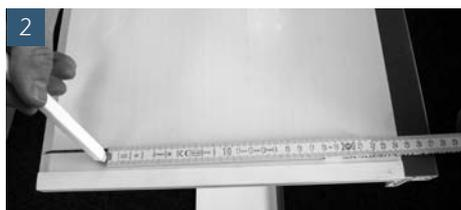
Ermitteltes Maß auf die Außenseite des höhenverstellbaren Aufstockelementes übertragen. Ausgehend von der Oberkante des höhenverstellbaren Aufstockelementes. (Dieser Punkt entfällt bei der Montage vom höhenverstellbaren Aufstockelement auf ein fixes Aufstockelement.)
