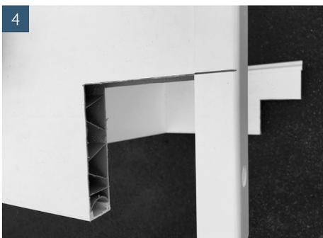
Wandanschlussprofil aufschieben und zuschneiden
