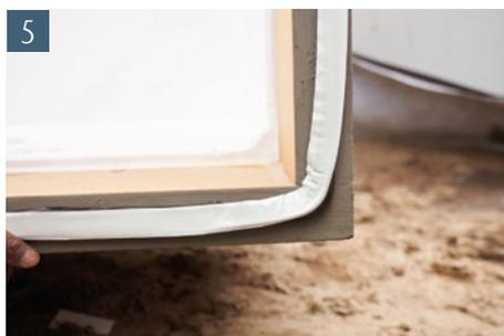
Reinigen Sie bzw. trocknen Sie die Kontaktfläche für das Dichtfix Abdichtungsband und kleben Sie es mittig auf. Je nach Lichtschachtgröße kommen zwei Abdichtungsbänder Dichtfix zum Einsatz, die verbunden werden müssen. Die Stoßfläche sollte immer im oberen Bereich des Lichtschachtes liegen. Entfernen Sie die Schutzfolie
