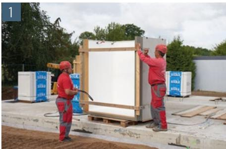
Bitte entfernen Sie vor der Montage die Transporthilfen, welche an den Befestigungswinkeln angeschraubt, sowie die beiden Holzleisten welche unterhalb des Lichtschachtbodens angeklebt sind
