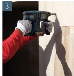
Bohren Sie die 16mm Befestigungslöcher und reinigen Sie diese im Anschluss mit einer Lochbürste. Sie können auch direkt durch die Montagewinkel bohren und diese so als Führung nutzen
