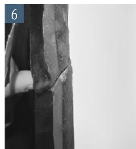
Bei Stößen ist das Dichtfix-Band unter 45° anzuschrägen und überlappend zu montieren
