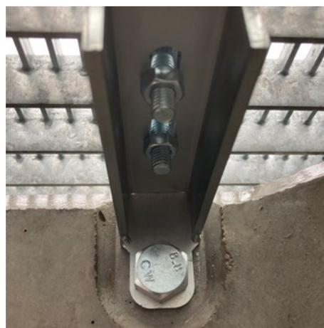
Montieren Sie zu allererst die 4 U-förmigen Konsolen mittels den Schrauben M16x30. Legen Sie anschließend die Konterplatte auf den Rost auf und verschrauben die Schlüssel-schrauben mit der Konsole
