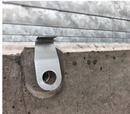
Stecken Sie die vier Abhebesicherungsbleche durch die vier Langlöcher im Tragstab des Rostes (zwei je Seite) und verschrauben Sie diese mit dem Lichtschacht
