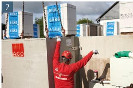
Bringen Sie den Lichtschacht vor die Kellerwand und richten Sie diesen aus. Zwischen Lichtschachtboden und Fensterbank empfehlen wir einen Abstand von ca. 30 cm. Markieren Sie die Befestigungspunkte. Die unteren beiden Befestigungen können über die nach unten hin offenen Langlöcher erfolgen. Die beiden oberen Befestigungswinkel müssen über die Rundlöcher mit der Kellerwand verschraubt werden. Alternativ können die Befestigungspunkte auch eingemessen werden
