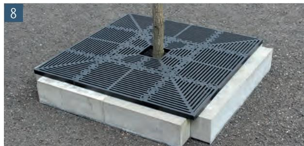
Nun können die Verschlüsse des gesamten Baumschutzrosts stufenweise und gleichmäßig verteilt angezogen werden. Hierbei können mehrere Durchgänge notwendig sein, bis alle Verschlüsse die gewünschte Vorspannung aufweisen
