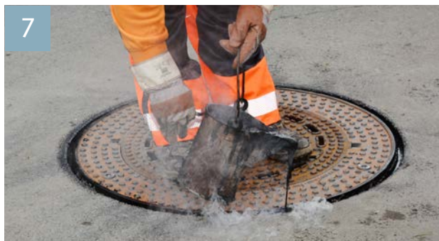
Die Anschlussfuge dauerelastisch vergießen
