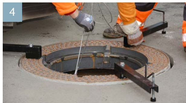
Beguplan Abdeckung einsetzen und auf Höhe ausrichten
