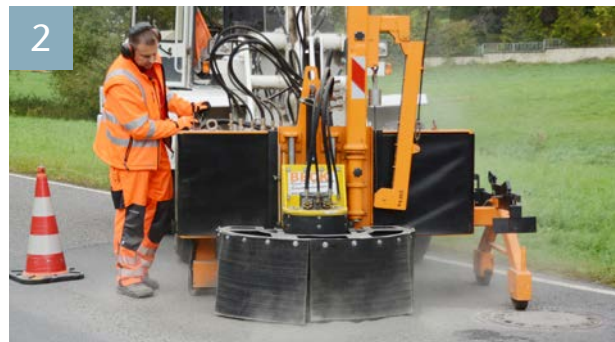
Schadhafte Abdeckung ausbohren
