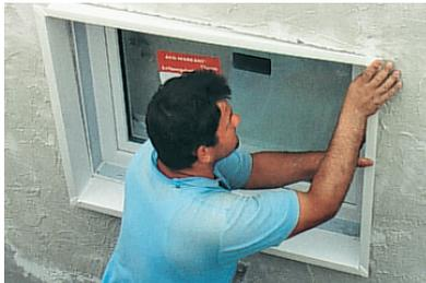
4. Zusammengesetztes Dämmungsanschlussprofil nach Abschluss der Wandbelagsarbeiten in die durch das Entfernen der Schalungsabdichtung freigewordene Nut einsetzen.
