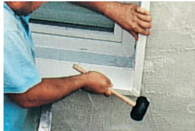
5. Durch Einschlagen in die Nut befestigen (z. B. Gummihammer). Abdichtung zwischen Dämmungsanschlussprofil und Fassade kann mit handelsüblichen Dichtstoffen (Fassadenkleber) erfolgen.
