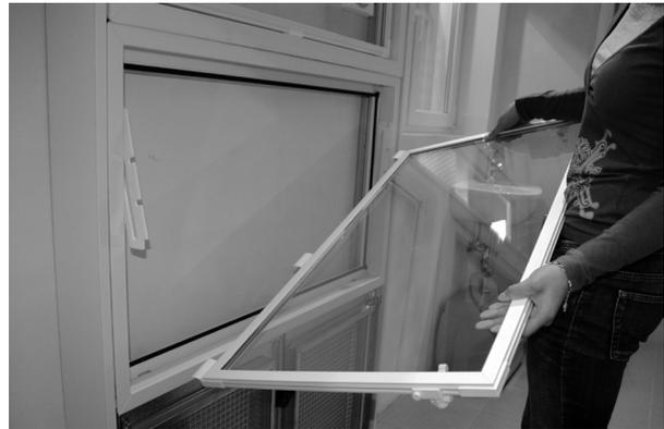
4. Der Flügel kann jetzt aus der unteren Führungsnut entnommen werden. Die Montage erfolgt in umgekehrter Reihenfolge!
