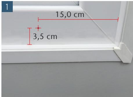
Von außen werden jeweils links und rechts zwei 8 mm Bohrungen gesetzt. Die Bohrungen sollten sich in 3,5 cm Höhe und von der Außenkante um 15 cm versetzt befinden.
