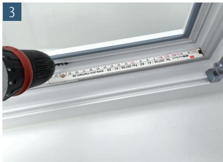
Von innen müssen ebenfalls zwei Bohrungen mit einem 4 mm Bohrer vorgenommen werden. Die inneren und äußeren Bohrungen sollten versetzt zueinander stehen, um Windgeräusche zu vermeiden. Im Idealfall sitzen die Bohrungen von der Innenkante der Zarge in einem Abstand von 20 cm entfernt. Durchbohren Sie im 45 Grad-Winkel die innere Wandung. Bitte achten Sie darauf, dass nicht tiefer als 1,5 cm gebohrt wird.
