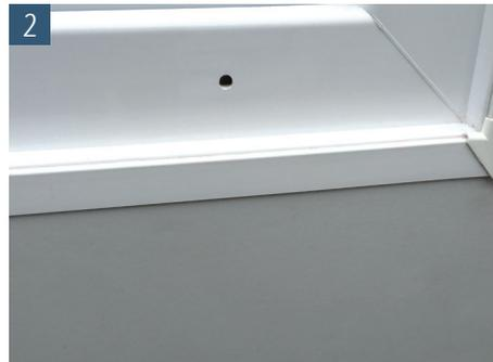
Bitte achten Sie darauf, dass nur die äußere Wandung des Fensterprofils durchbohrt wird.
