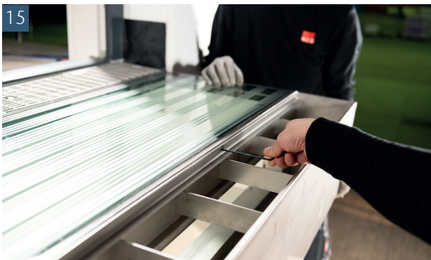
Verschrauben Sie nun den Lüftungskasten über die im Glasrahmen befindlichen Gewindebohrungen
