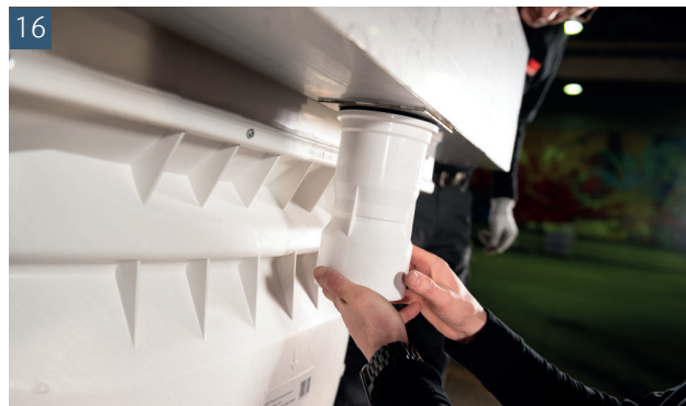
Bringen Sie nun den Entwässerungsanschluss bzw. Rückstauverschluss an und schließen diesen an die Entwässerungsleitung an. Bitte beachten Sie hierbei die Installationshinweise der beigegeführten Einbauanleitung
