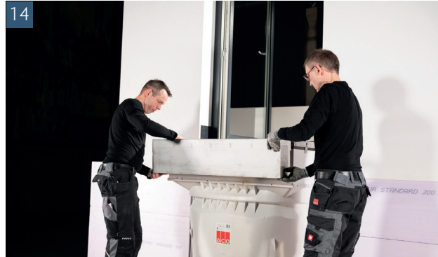
Nehmen Sie den Lüftungskasten zur Hand und führen Sie den Lüftungsstutzen in die Aussparung des Aufstockelementes ein
