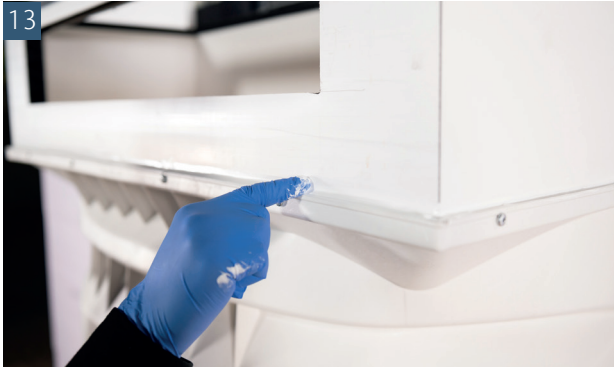
Nach dem Ausfügen können Sie mit der Montage des Lüftungskastens fortfahren
