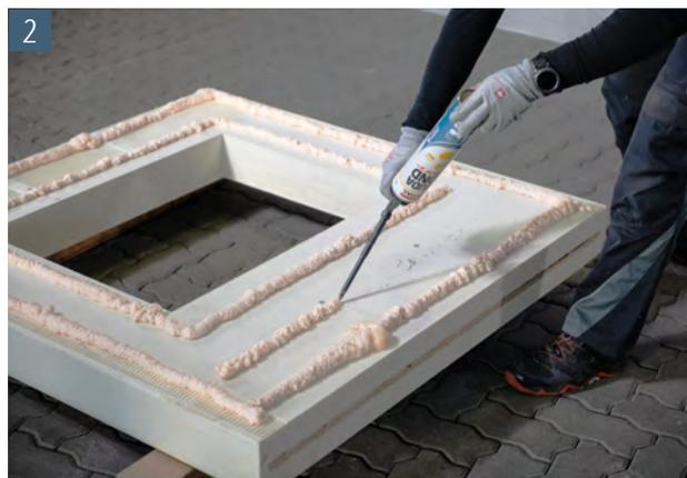
Ausreichend Dämmplattenkleber wie dargestellt aufsprühen. ACO Therm® Block mit Fensterausparung: ca. ½ Dose ACO Therm® Block mit integrierter Zarge: ca. ¾ - 1 Dose
