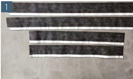
1 Bei der Verwendung von ACO Therm® Block mit integrierter Zarge in der Standardausführung müssen die Abdichtungsfolie entsprechend der vorhandenen Leibungsgröße zugeschnitten werden. Die seitlichen Folien müssen in der Länge genau der Höhe der Leibung entsprechen. Die untere und obere Folie sollte jeweils 4 cm länger sein, als die Breite der Leibungsöffnung.
