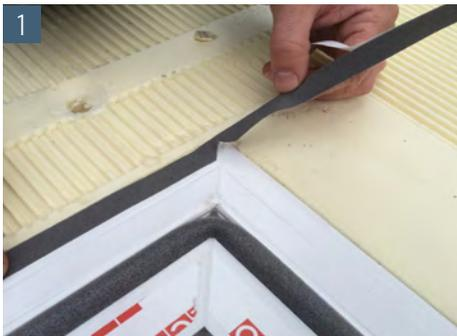
1 Vor dem Ankleben des Therm® Blocks das Kompriband am äußeren Rand des Abdichtungsflansches der Zarge aufkleben. Ecken mit Hilfe eines V-förmigen Ausschnitts ausbilden
