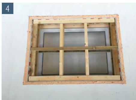
4 Aussteifungsrahmen einfügen und Leibungselement rundum einschäumen.
