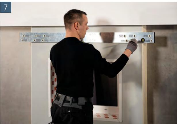
7 Markieren Sie die oberen Befestigungspunkte des Lichtschachtes. Hierzu kann die ACO Bohrschablone genutzt werden.
