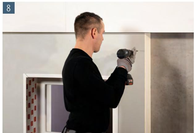
8 Die beiden oberen Befestigungspunkte mit Tellerkopfschrauben ohne Beilegescheibe bestücken. Drehen Sie die Schrauben bis auf ca. 3 cm ein.
