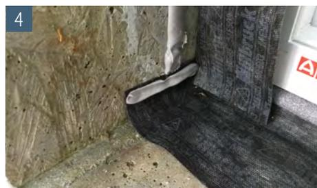
4 Tragen Sie nun den Kleber unterhalb der Dichtungsfolie umlaufend in die Leibung und im Stoßbereich der Folien lückenlos auf.
