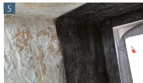
5 Im Anschluss kann die Dichtungsfolie mittels Anpressrolle mit der Leibung verklebt werden.
