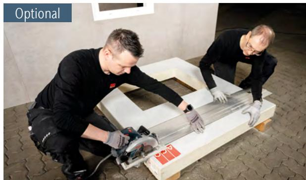
Sofern der Therm Block oberseitig gekürzt werden sollte, kann dies mit einer Kreissäge mit feinzahnigem Sägeblatt erfolgen.
