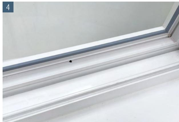
Entfernen Sie abschließend die Bohrspäne.
