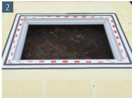
2 Kompriband etwas aufquellen lassen
