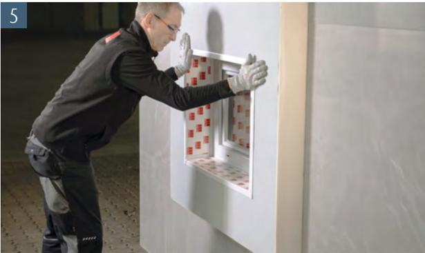
5 Fügen Sie das Dämmungsanschlussprofil laut beiliegender Anleitung zusammen und klicken dieses in die Dichtungsnut des Fensters ein.
