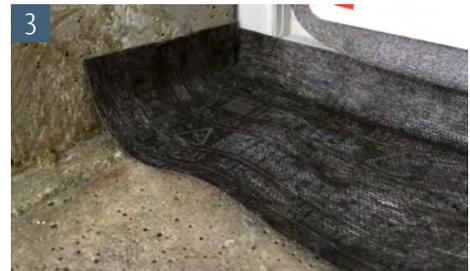
3 Nun können die Dichtungsfolien an den innenseitig sichtbaren Zargenabdichtungsflansch angeklebt werden. Beginnen Sie bitte mit den oberen und unteren Folienabschnitten. Entfernen Sie hierzu die Schutzfolie des Selbstkelbestreifens. Beidseitig müssen diese beiden Folien jeweils 2 cm überstehen. Im Anschluss können die beiden seitlichen Folien angeklebt werden.
