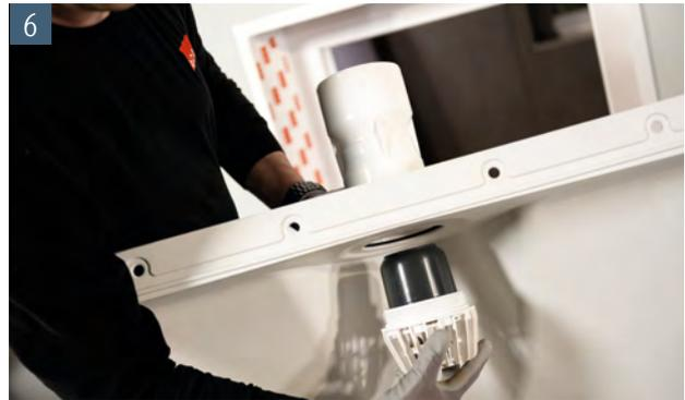
6 Installieren Sie den Entwässerungsanschluss, Rückstauverschluss oder Verschlussdeckel entsprechend den beiliegenden Anleitungen.
