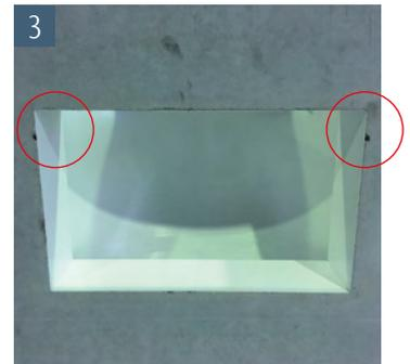
3 Entfernen Sie am Schalungselement die Gummiblöcke (ca. 85 mm von oben gemessen liegend) und legen Sie die Bolzenöffnungen frei.
