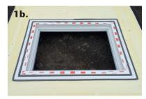
Das im Montageset enthaltene Kompriband am äußeren Rand des Abdichtungsflansches der Zarge aufkleben. Ecken mit Hilfe eines V-förmigen Ausschnitts ausbilden
