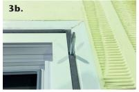
In die beiden oberen Bohrungen in der im Therm® Block befindlichen Fernsterzarge einen Montagebolzen (Art.-Nr. 380398) einstecken
