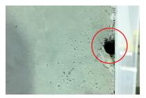
Auf der Außenseite des Schalungselementes (83 mm von oben gemessen) sind links und rechts jeweils ein schwarzer Gummipuffer zu finden. Diese Gummipuffer und ggf. darunter befindliche Betonschlämme entfernen, so dass die Bohrungen frei zugänglich sind
