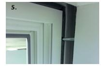
ACO Therm® Block zum Schalungselement führen und Montagebolzen in die Schalungselement-Bohrungen einführen. Therm® Block vollflächig gegen Wand drücken und im Anschluss mittels 2 Kanthölzern und Schraubzwingen mit der Wand verpressen. Trocknungszeit: ca. 1 Stunde. Bitte folgenden Sie nun den weiteren Montageschritten entsprechend der im Therm® Block-Montageset enthaltenen Montageanleitung
