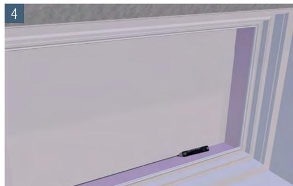
Übertragen Sie die Fensterausparung auf die Rückseite der Rückwand. Achten Sie darauf, dass die Dämmung unmittelbar an die Schalungsdichtung bzw. der Einstecknut des Leibungskellerfensters angearbeitet ist, so dass der Fensterauschnitt nicht zu groß ausfällt
