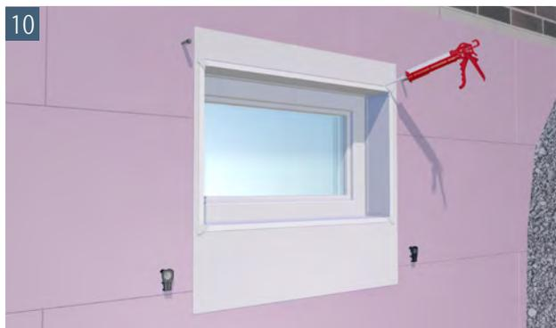
10 Dichten Sie das Dämmungsanschlussprofil oberseitig ab
