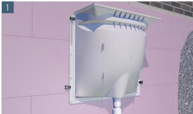
Montieren Sie den Lichtschacht und richten diesen final in der Höhe aus
