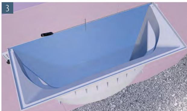
Markieren Sie die Oberkante der Rückwand und setzen Sie zudem eine senkrechte Markierung zur späteren Orientierung
