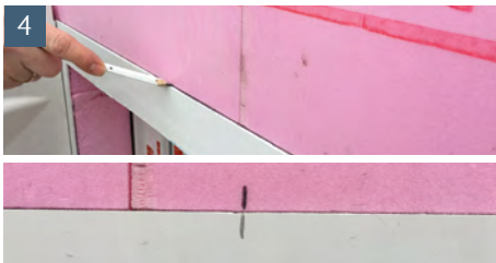
Horizontale Rückwandposition auf Dämmung oder Wand markieren. Vertikale Rückwandposition auf Dämmung oder Wand und Rückwand markieren. Rückwand und Lichtschacht demontieren
