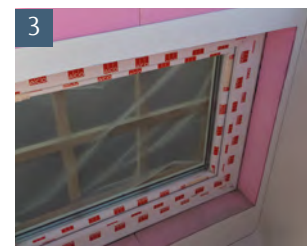
Rückwand entnehmen. Fensterausschnitt mittels Stichsäge ausschneiden. Schutzfolie entfernen. Rückwand wieder einschieben und ausrichten
