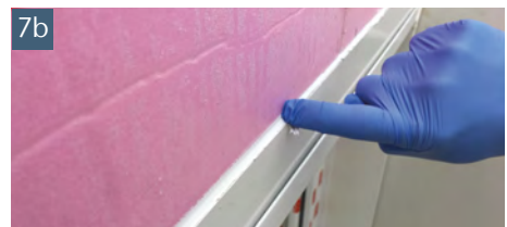
Dichtstoff nochmals im Übergang von Rückwand zu Dämmung oder Wand auftragen. Dichtstoff glätten
