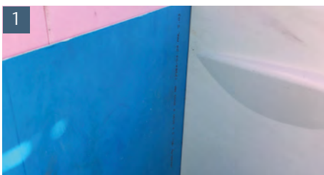
Rückwand in wandseitige Lichtschachtnut einschieben. Optional
