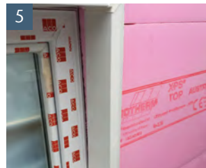
Dämmungsanschlussprofil gemäß Montageanleitung zusammenbauen. Rahmendichtung entfernen. Dämmungsanschlussprofil durch Rückwand schieben und in Rahmennut einstecken
