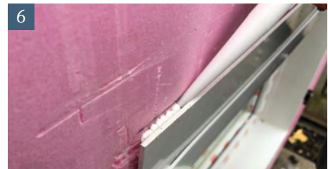
Dichtstoff oberseitig hinter die Rückwand eintragen. Rückwand gemäß Markierungen ausrichten und andrücken. Lichtschacht anschrauben. Rückwandposition nochmals prüfen. Ggf. korrigieren
