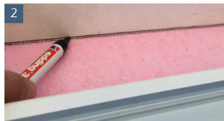
Fensterausschnitt von innen markieren. Hierzu an vorhandener Dämmung orientieren. Bitte Außenabmessung des Dämmungsanschlussprofils berücksichtigen. Ggf. Dämmung nachschneiden
