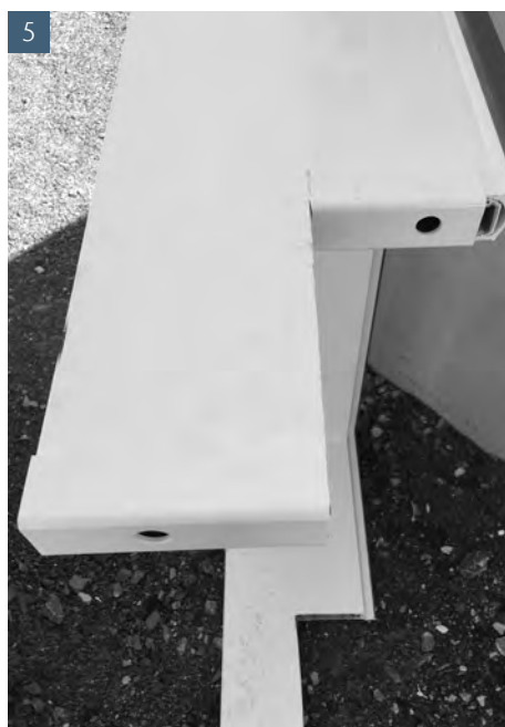
Wandanschlussprofil aufschieben. Nun kann das Aufstockelement montiert werden.
