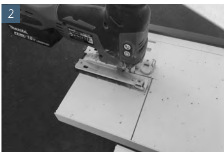
Ausklinkung mit Stichsäge vornehmen
