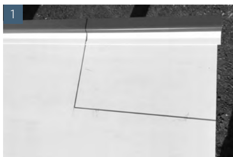
Wandanschlussprofile entfernen. Auszuklinkenden Bereich anzeichnen
