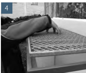
Rost mittig anheben und entnehmen
