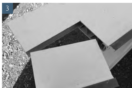
Ausklinkung mit Stichsäge vornehmen
