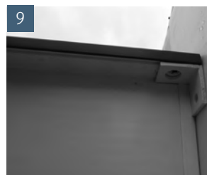
Winkel unter die Rostauflage kleben
