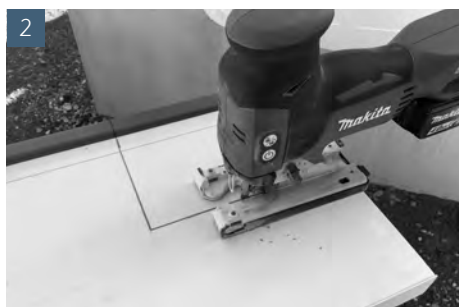
Ausklinkung mit Stichsäge vornehmen
