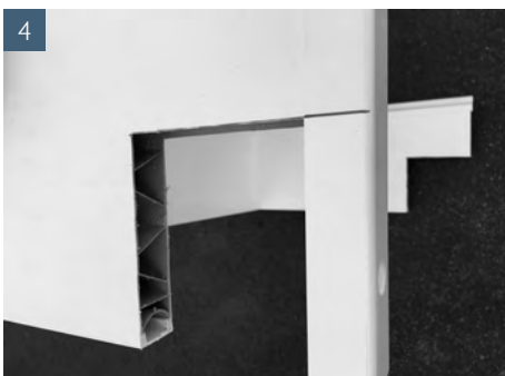
Wandanschlussprofil aufschieben und zuschneiden
