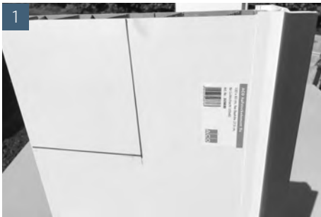
Wandanschlussprofile entfernen und Ausklinkung anzeichnen
