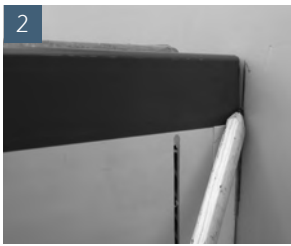
Außenkante des Aufstockelements (Seitenschenkel) anzeichnen
