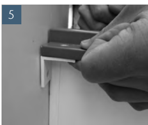
Kunststoffwinkel anhalten. Große Bohrung zeigt nach oben
