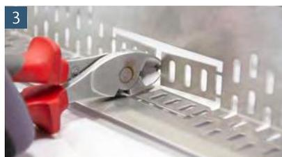
3 Der Stichkanal kann durch einfaches Öffnen der Kiesleiste angesetzt werden
