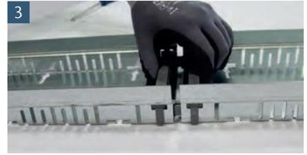
Rinnenkörper so aneinander setzen das sie fluchten, dann mit leichter Kraft beide Riegel zusammendrücken
