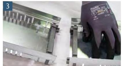
Den zu entfernenden Rinnenkörper anheben, dabei trennt sich die Verbindung selbständig.
