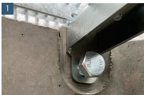
Schrauben Sie die 4 U-Konsolen mit den Sechskantschrauben M 16x30 innenseitig am Betonlichtschacht an
