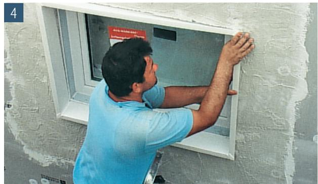
Zusammengesetztes Dämmungsanschlussprofil nach Abschluss der Wandbelagsarbeiten in die durch das Entfernen der Schalungsabdichtung freigewordene Nut einsetzen.
