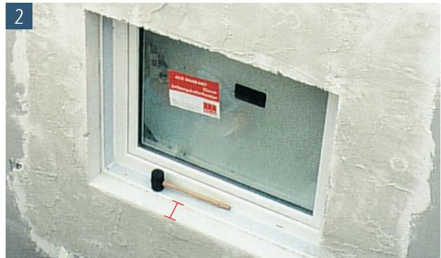
Dazu wird das Profil an der entsprechenden Sollbruchstelle mit einem Cuttermesser zwei- bis dreimal geritzt und abgebrochen. Soll nur ein 5 mm Streifen entfernt werden, bitte eine Zange zu Hilfe nehmen. Die Eckverbinder an der entsprechenden Stelle abschneiden.
