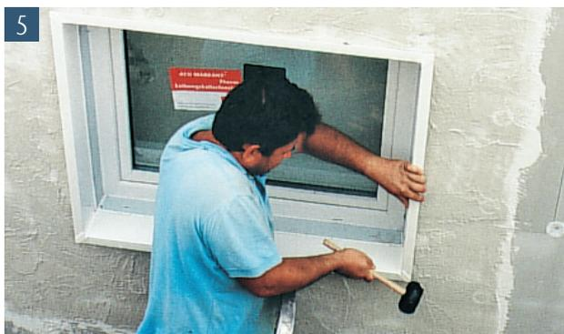
Abdichtung kann mit dauerelastischen handelsüblichen Dichtstoffen erfolgen (z. B. ACO Artikel: 327830). Das Befestigen der Dämmanschlussprofile seitlich und oben kann mit Fassaden- bzw. Dämmplattenkleber erfolgen (z. B. ACO Artikel: 327830). Hier sollte während der Trocknung ausgesteift werden.
