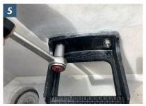
Steigeisen mit 25 Nm Drehmoment anschrauben
