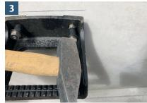
Anker durch die Bohrungen im Steigeisen im Durchsteckverfahren setzen.
