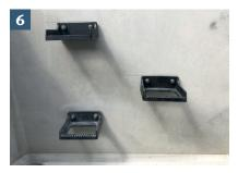
Weitere Steigeisen entsprechend der Schachthöhe setzen.
