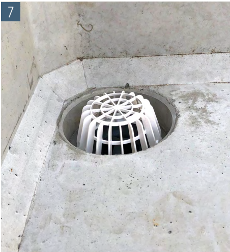
7 Montieren Sie den Rückstauverschluss, den Entwässerungsanschluss oder den Verschlussdeckel
