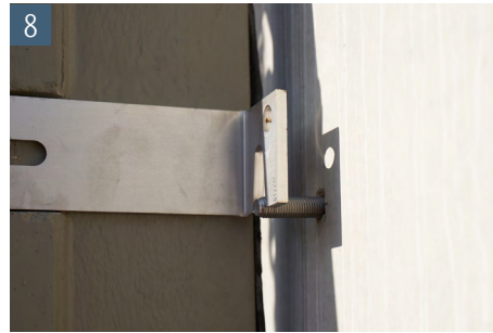
8 Setzen Sie den Lichtschacht auf den beiden unteren Schlaganker auf. Halten Sie das Abdichtungsband so lange auf Abstand zur Kellerwand, bis der Befestigungswinkel kraftschlüssig auf dem Schwerlastanker aufliegt. Erst dann darf der Lichtschacht gegen die Kellerwand gedrückt werden. Ggf. ein Brett oder ähnliches zwischen Befestigungswinkel und Kellerwand als Abstandhalter platzieren
