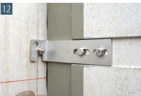
12 Ziehen Sie nach 10 Minuten die Muttern erneut über Kreuz an, so dass das Dichtungsband dichtfix bis auf 3 mm zusammengedrückt wird
