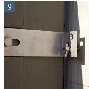
9 Schrauben Sie Scheibe und Mutter zur Sicherung des Lichtschachtes auf. Schlagen Sie den Schwerlastanker bis auf ca. 3 cm weiter ein
