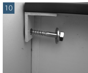
Schraube mit Beilagscheibe in Spiraldübel eindrehen
