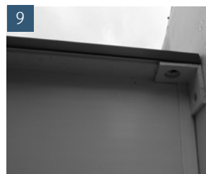
Winkel unter die Rostauflage kleben
