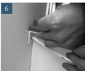
Seitenschenkel gegen äußere Markierung (Punkt 2) drücken und Befestigungspunkt anzeichnen
