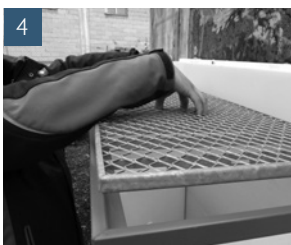
Rost mittig anheben und entnehmen
