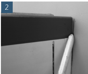
Außenkante des Aufstockelements (Seitenschenkel) anzeichnen
