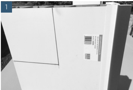
Wandanschlussprofile entfernen und Ausklinkung anzeichnen
