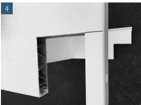
Wandanschlussprofil aufschieben und zuschneiden
