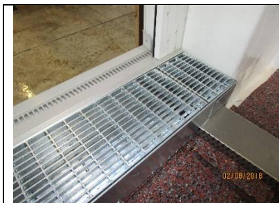
Schlitzrinne mit Maschenrost und Stichkanal
