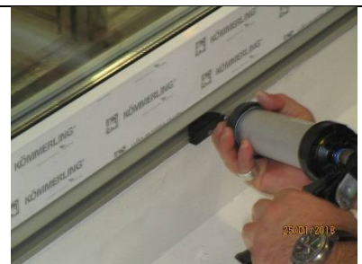
Abfugen des Abdichtungshochzuges mit EVATAACK
