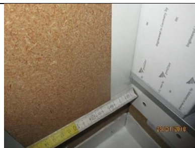
Montierte Edelstahl-Verbundbleche mit Anschlussflansch für Kunststoffbahnenabdichtung aus EVALON
