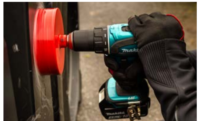
Unten am Tank mit der Lochkreissäge ein Loch für den Anschluss der Retentionsdrossel herstellen
