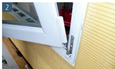
2 Fensterflügel mittels der Griffolive in Drehstellung bringen und auf das Ecklager aufsetzen
