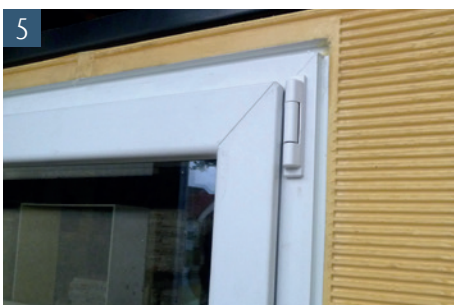
5 Abdeckkappe für Axerlager aufstecken
