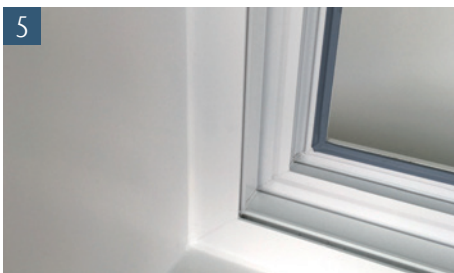
5 Übergang von Fensterzarge zum Leibungselement abdichten
