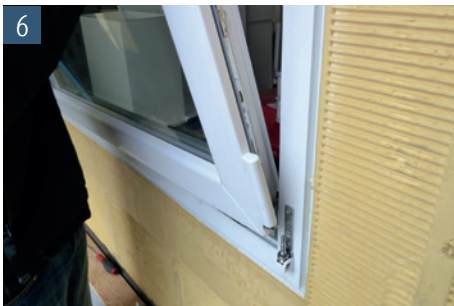
6 Flügel anschließend vom unteren Ecklager heben
