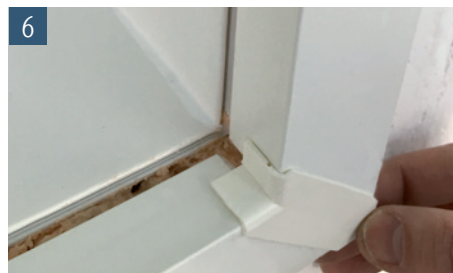
6 Abdeckwinkel zusammenstecken und in Dichtungsnut einklicken
