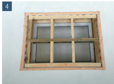
4 Aussteifungsrahmen einfügen und Leibungselement rundum einschäumen
