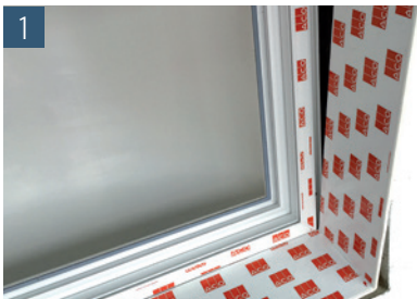
1 Nach erfolgter Therm® Block-Montage das Leibungselement in die Nut der Fensterzarge einschieben
