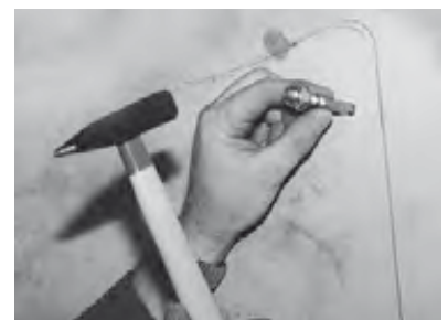
5. Die beiden oberen Schwerlastdübel einschlagen.
