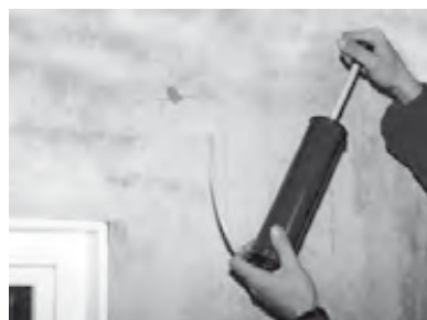
4. Bohrlöcher reinigen.
