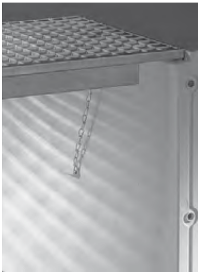
2. Lichtsachtrost einsetzen und Rostabbesicherung einbauen.
