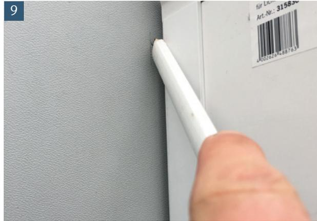
9 Markieren Sie beidseitig die Lage (Außenseite) der Wandanschlussprofile und der Befestigungspunkte. Zum Markieren der Befestigungspunkte Wandanschlussprofile vom Aufstockelement nehmen. Achten Sie bitte darauf, dass die Wandanschlussprofile richtig herum positioniert werden. Kurzer Lochabstand muss oben sein
