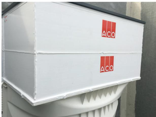
Überarbeiten Sie nun alle Übergänge an den Bauteilen und zur Wand bzw. zum Therm Block, sowie die Schweißnähte am Aufstockelement mit dem Dichtstoff (Superfix Extrem)
