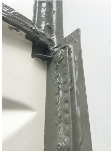
18. Überstreichen Sie nun mit dem Pinsel alle zuvor abgedichteten Übergänge mit dem Dichtstoff Aqua Blocker. Achten Sie bitte auf ein durchgängiges Oberflächenbild ohne Fehlstellen. Das Rostzapfenloch muss von unten ebenfalls überstrichen werden
