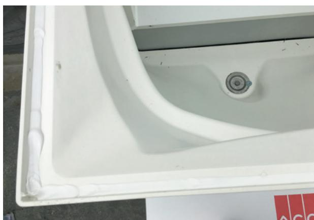
Dichtstoff (Superfix Extrem) umlaufend ( $\varnothing$  ca. 7 mm) in die Rostaufnahme des Lichtschachtes eintragen. Bitte achten Sie darauf, dass die Rostzapfenlöcher am Ende der Rostaufnahme ausreichend geschlossen werden
