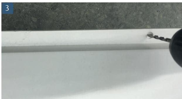
Durchbohren Sie die Befestigungspunkte (Vorperforierungen innen) in der Rostkante des Lichtschachtes mit einem 4 mm Bohrer (vorne 4x, seitlich 2x)
