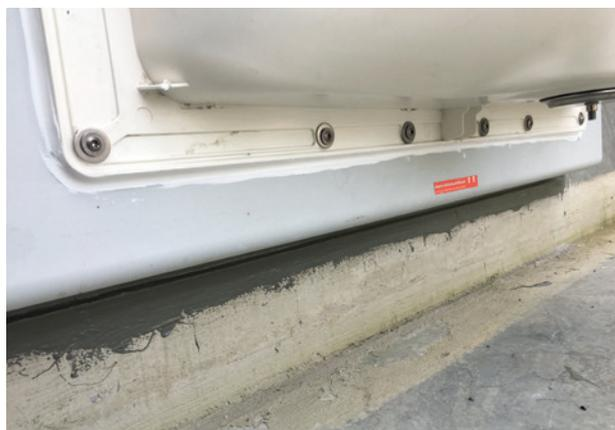
Füllen Sie die beiden oberen Langlöcher am Lichtschacht komplett mit Dichtstoff (Superfix Extrem) aus. Fügen Sie zudem den Übergang von Lichtschachtflansch zum ACO Therm® Block bzw. zur Betonwand ab
