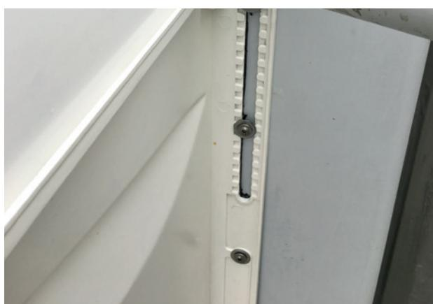
Schieben Sie das Aufstockelement/die Aufstockelemente in die montierten Wandanschlussprofile ein und drücken das Aufstockelement/ die Aufstockelemente in die Rostaufnahme des Lichtschachtes. Spritzen Sie nun den Spalt zwischen dem Aufstockelement und der Lichtschachtrostkante mit dem Dichtstoff (Superfix Extrem) aus
