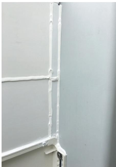
17. Überarbeiten Sie nun den Dichtstoff bei allen Übergängen mit dem Finger. Achten Sie darauf, dass nicht zu viel Dichtstoff abgetragen wird. Überarbeiten Sie bitte auch nochmals das Rostzapfenloch der Lichtschachtrostaufgabe von unten. Dichtstoff ca. 1 Stunde aushärten lassen
