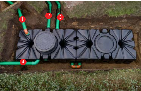
Beispielhafter Aufbau eines Regenwassertanks mit 4.000 l mit Nutzung als Retention und Regenwasserspeicher
