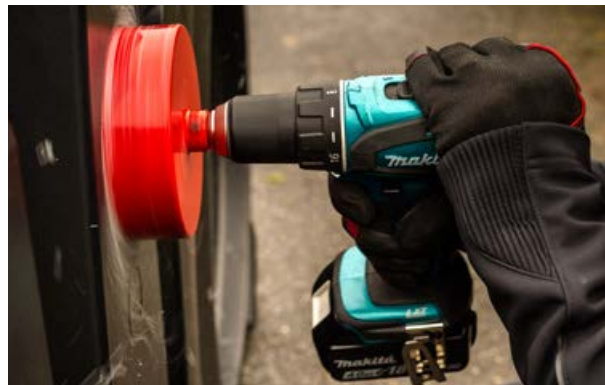
Unten am Tank mit der Lochkreissäge ein Loch für den Anschluss der Retentionsdrossel herstellen
